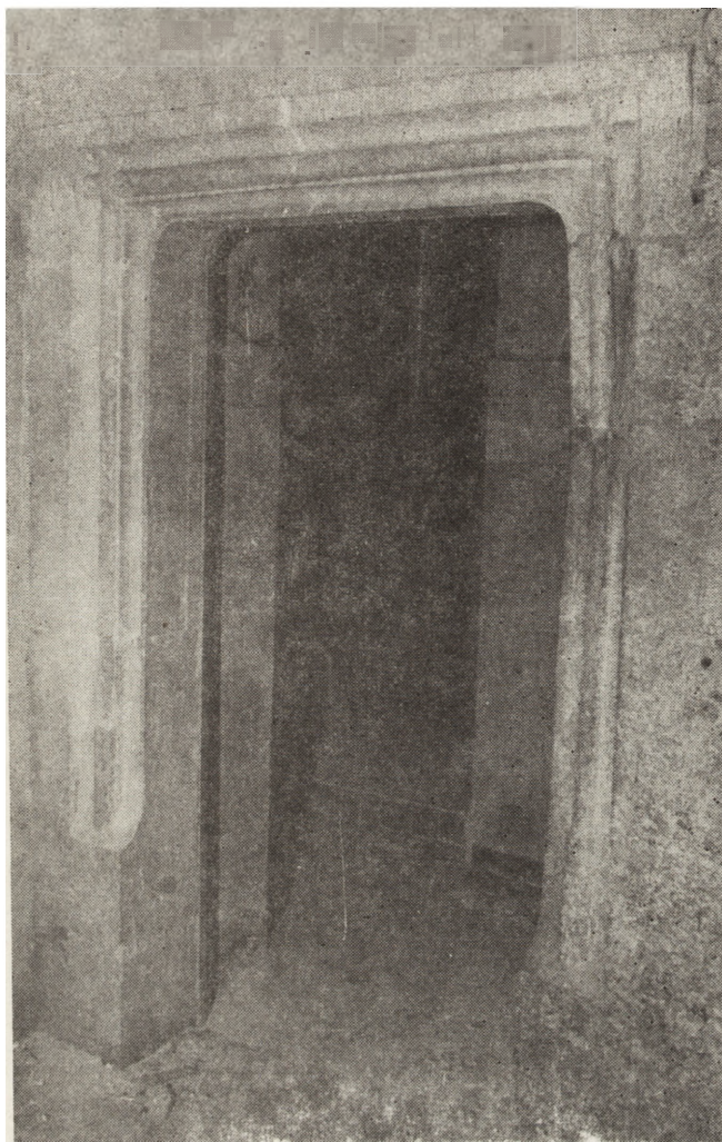
10. Kraków, ul. Floriańska 11, kamienny portal odkryty w tylnej ścianie sieni, po uzupełnieniu i konserwacji (fot. MBP, Kraków 1978)
