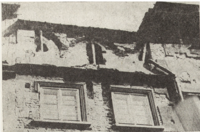
1. Kraków, ul. Floriańska 11, widok górnej części elewacji frontowej z odkrywkami. W górnych odkrywkach widoczne fragmenty grzebienia attyki. Poniżej, między oknami trzeciego piętra widoczny jest wypreparowany z późniejszej zamurówki jeden z pilastrów fryzu arkadowego attyki (fot. PKZ, Kraków 1971)
