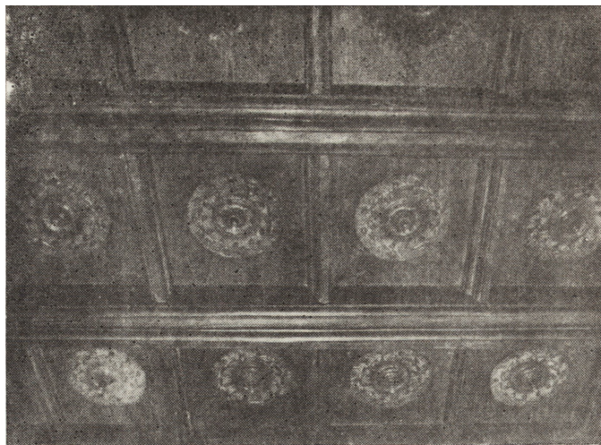
12. Kraków, ul. Floriańska 11, drewniany strop z renesansowymi rozetami z masy papierowej odkryty w pomieszczeniu frontowego traktu na pierwszym piętrze, po konserwacji (fot. MBP, Kraków 1979)
