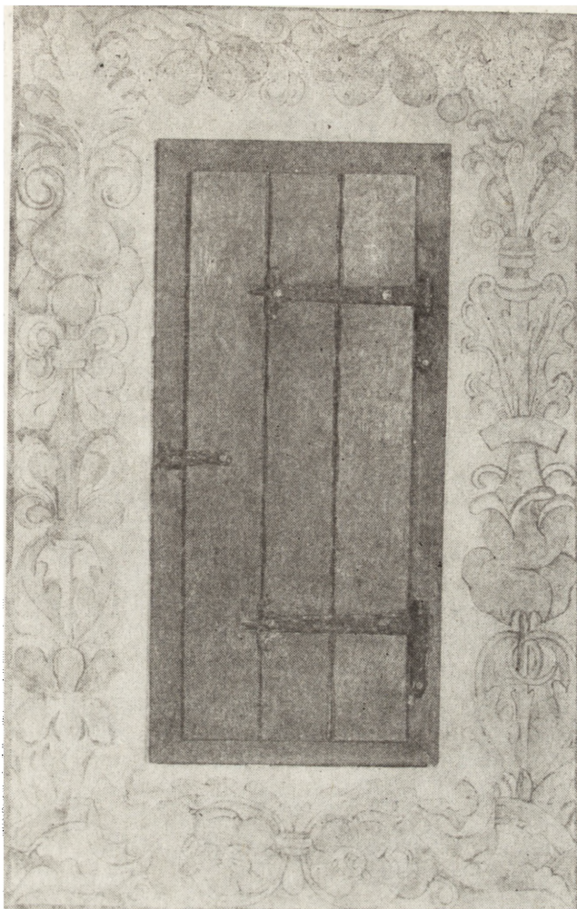
14. Kraków, ul. Floriańska 11, jedna z almarii odkrytych w pomieszczeniu frontowym pierwszego piętra, po częściowej rekonstrukcji i konserwacji polichromowanej bordiury i wykonaniu brakujących drzwiczek (fot. MBP, Kraków 1978)
