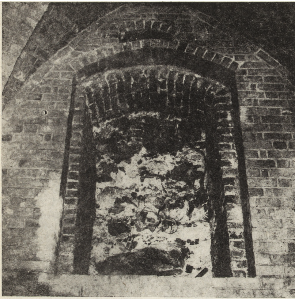
6. Zamek – Dom Duży, piwnica gotycka o jednym słupie, ściana zachodnia. Portal wieżyczki schodowej z czasów Zygmunta Augusta z prześwitem wypełnionym głazami fundamentu Wieży Władysławowskiej (stan przed przebudową). W górze relikw wywietrznika piwnicy (fot. G. Solecki)
