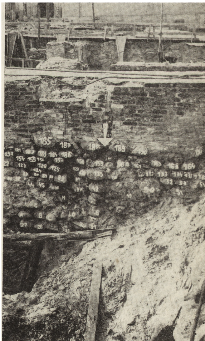
5. Zamek – skrzydło północno-wschodnie, kamienny fundament budynku z dostawionym posadowieniem ściany z okresu budowy wazowskiej. Strzałka wskazuje styk obu murów (fot. T. Biniewski)
