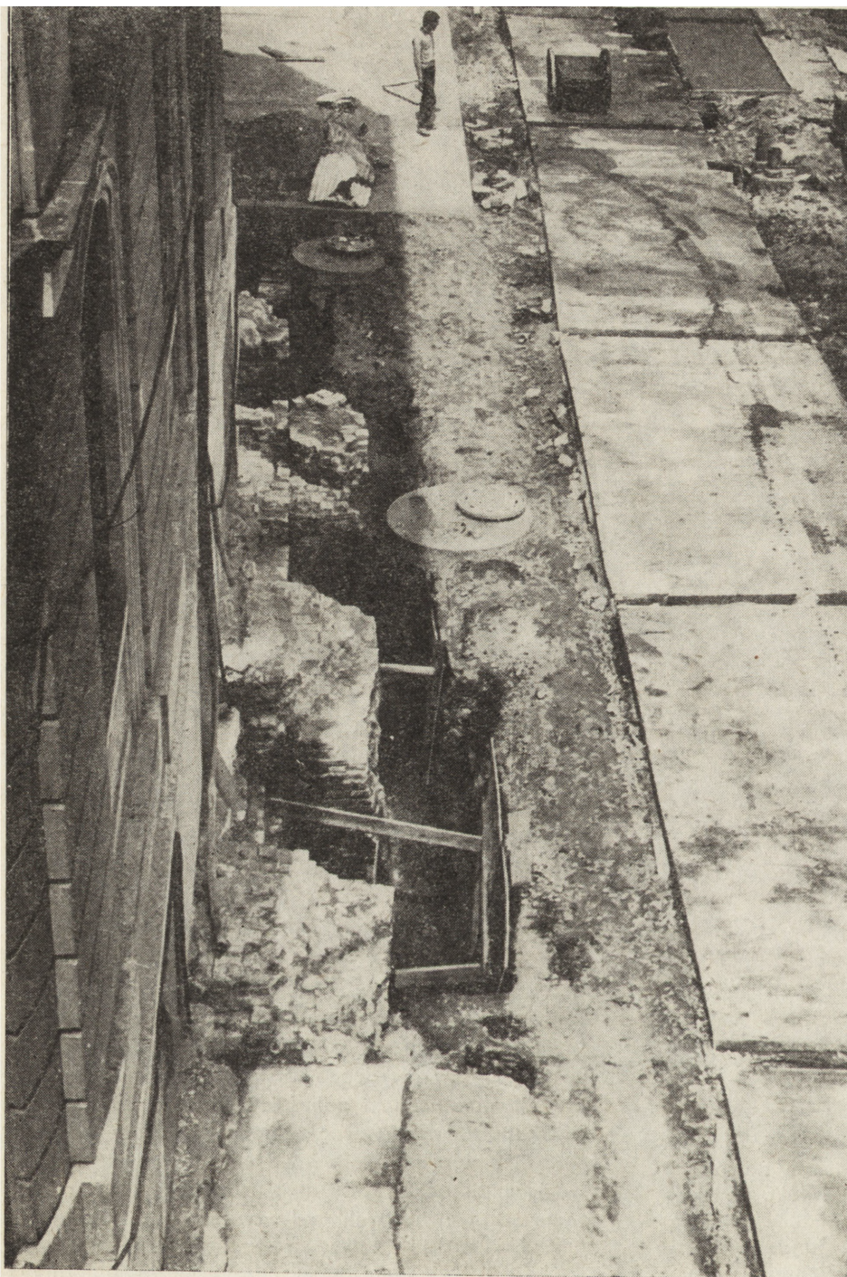
4. Zamek – ryzalit środkowy – elewacja wschodnia. U dołu widoczny pas tzw. zerowego poziomu fundamentu z posadowieniami lizen, które wspierały balkon I piętra (fot. G. Radzikowska)
