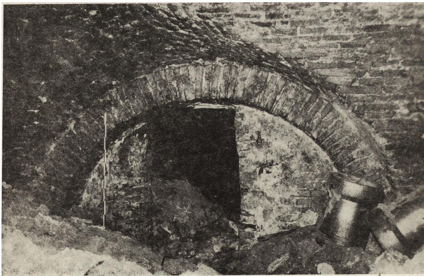
12. Ulica Podwale 2 – piwnica wschodnia, arkada portalu w ścianie działowej, zabudowana w XIX w. ścianką z otworem drzwiowym. Po prawej rury kamionkowe, którymi zamaskowane było północne wejście do piwnicy w czasie okupacji, gdy wyrabiano tu granaty ręczne (fot. G. Kułakowska)
