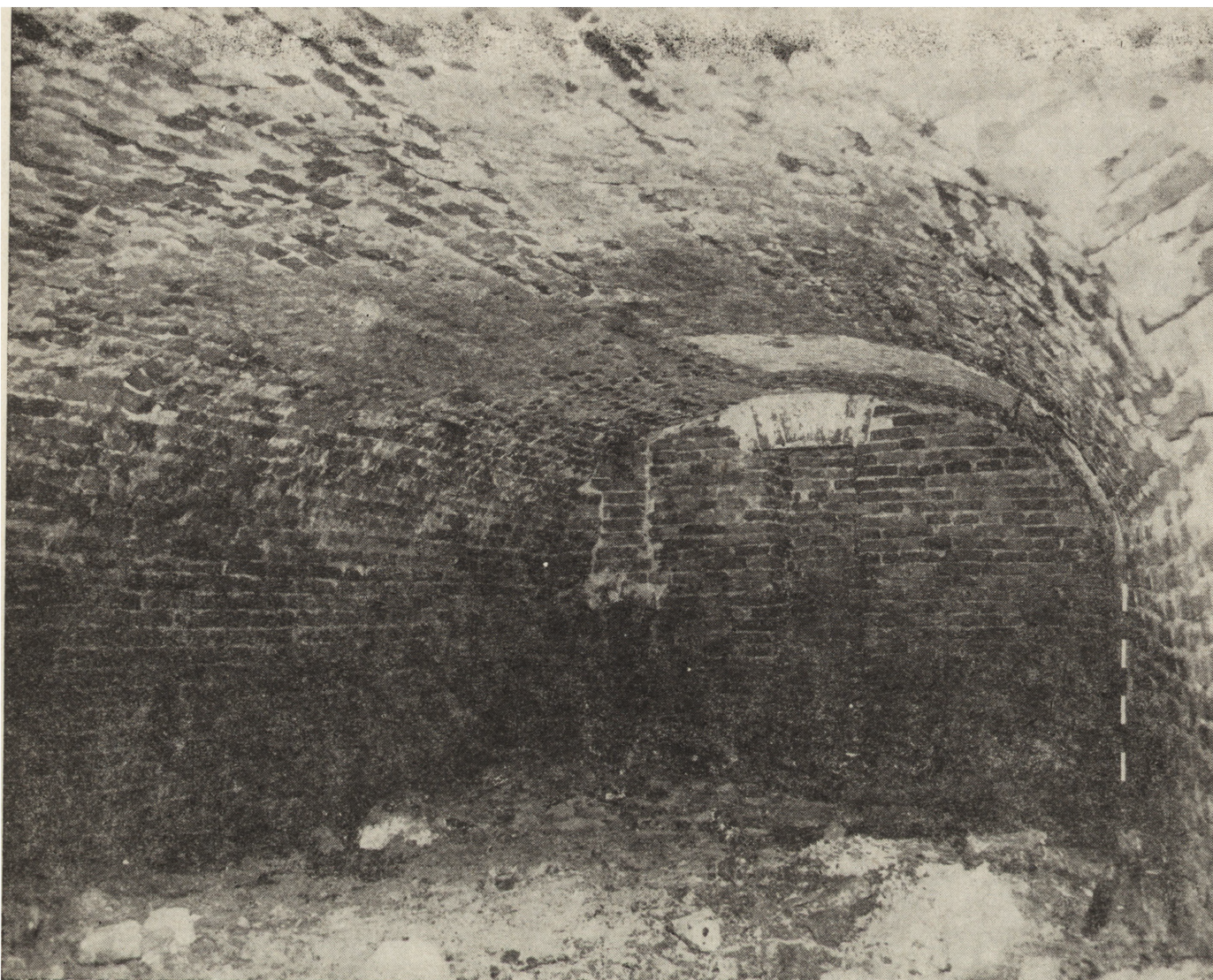
13. Ulica Podwale 4 – piwnica zachodnia, widok ku północy (fot. G. Kułakowska)
