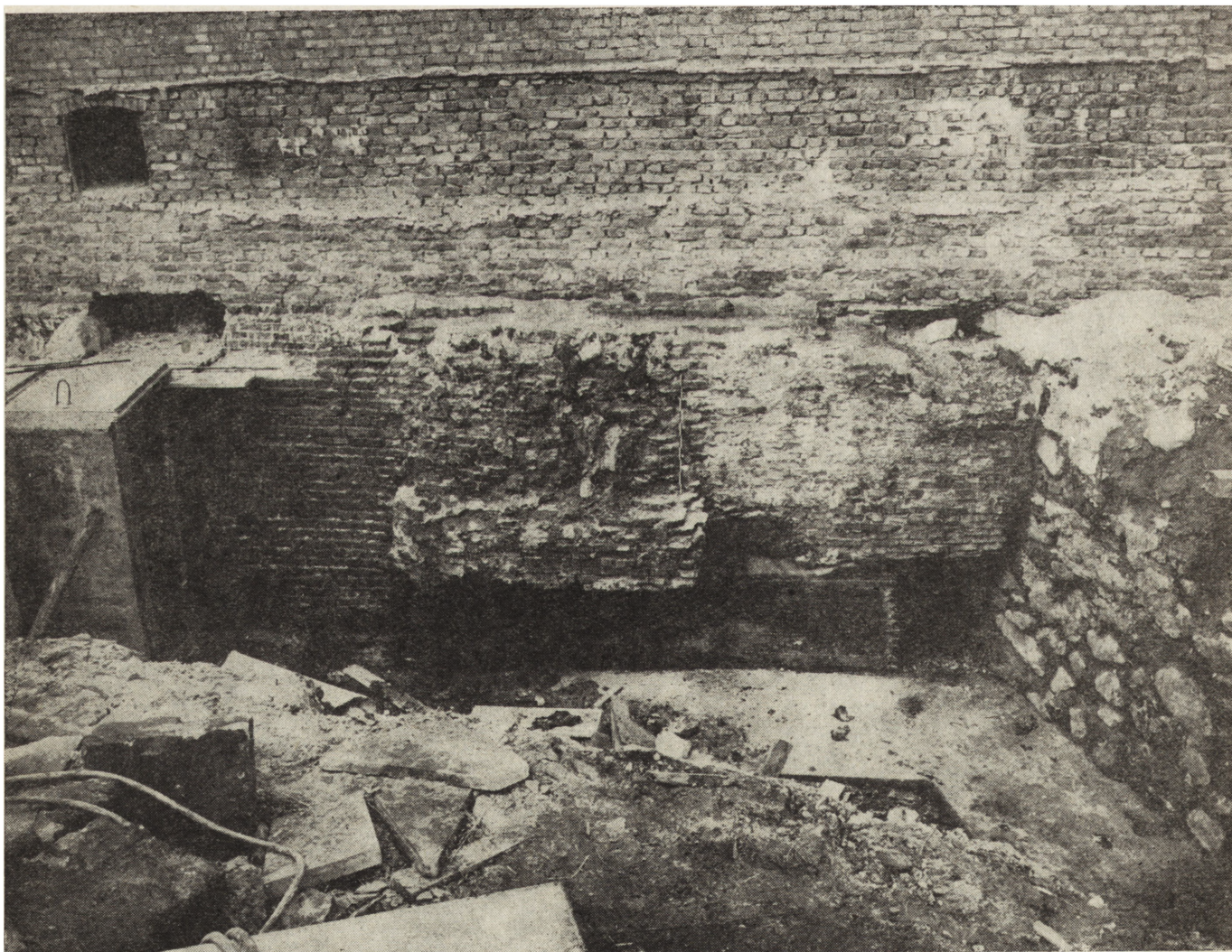
2. Zamek – Dom Duży, ściana wschodnia. Po lewej skarpa na rożnika północno-wschodniego Domu, po lewej i u dołu – korytarz izolacyjny w budowie (fot. G. Radzikowska)
