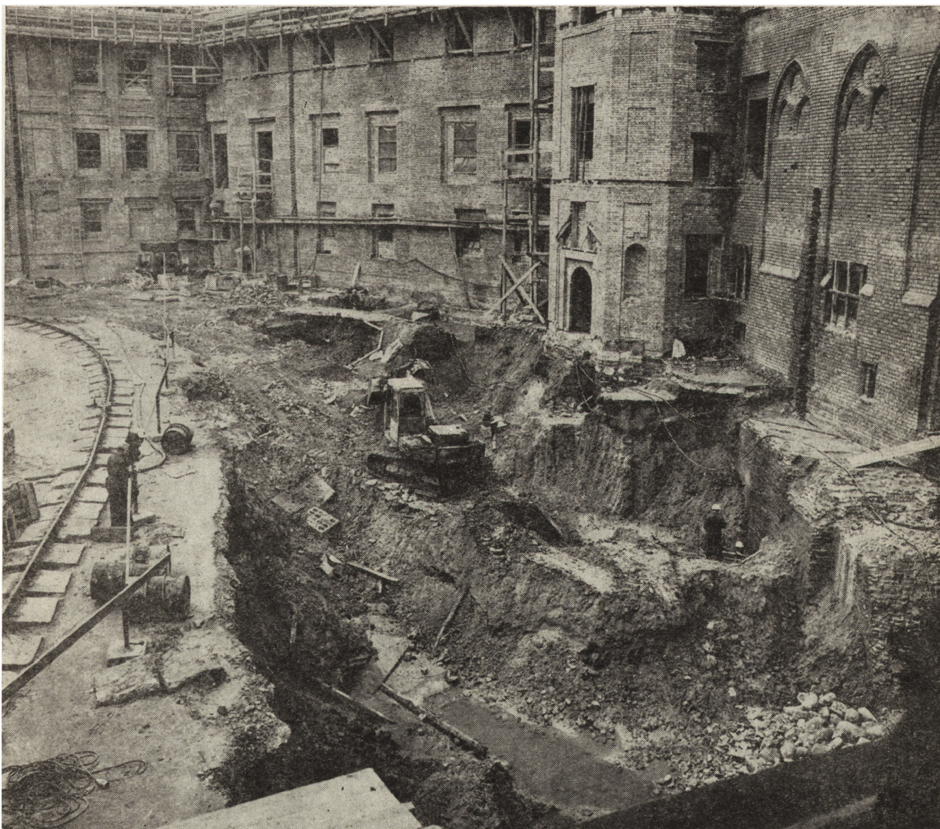
7. Zamek – Działek Wielki, część wschodnia z Wieżą Władysławowską i Domem Dużym. Przed elewacją Domu (po prawej) widoczny fundament nie zrealizowanej przebudowy według projektu Dominika Merliniego (fot. M. Dąbski)
