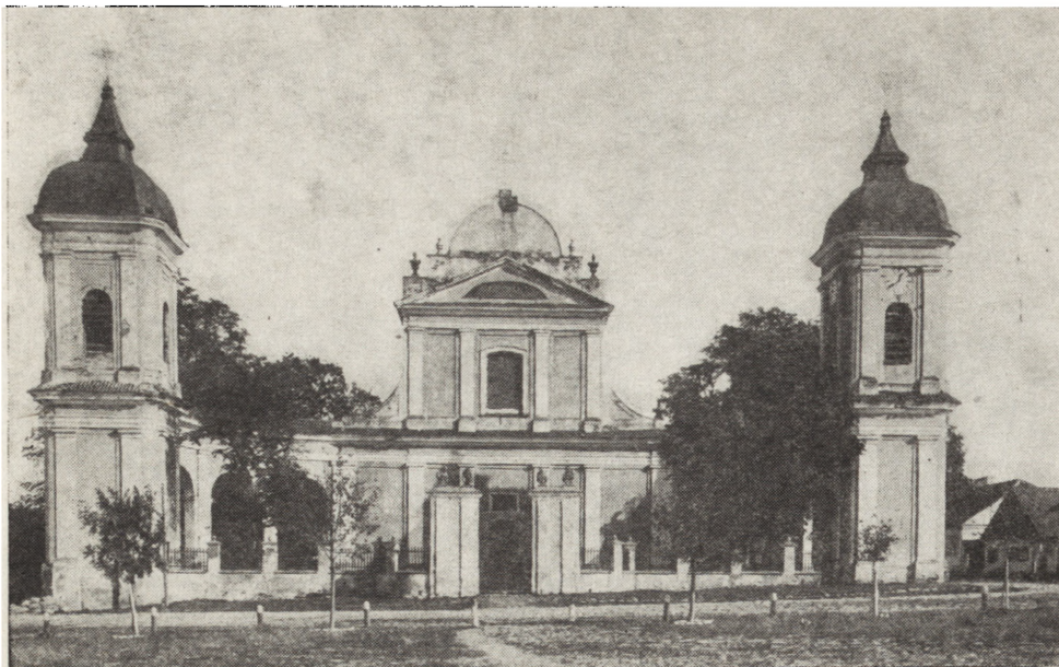
14. Tykocin, kościół p.w.Św. Trójcy, fasada, 1936 r. (fot. J. Glinka, neg. IS PAN)
