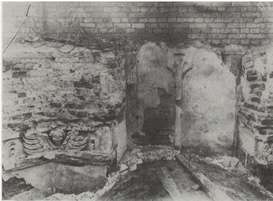
11. Grodno, kościół farny, niezidentyfikowany fragment wnętrza w trakcie prac konserwatorskich (zbiory IS PAN)
