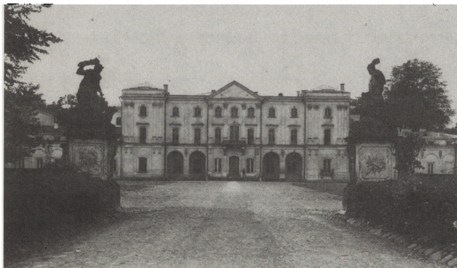
12. Białystok, pałac Branickich — widok na elewację frontową, stan po 1918 r. (zbiory IS PAN)
