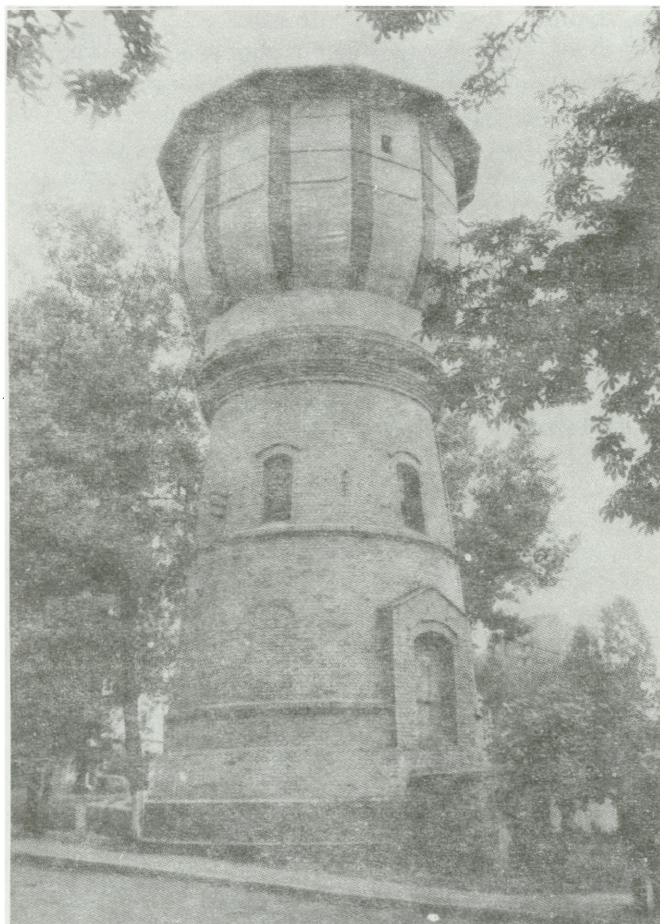
8. Katowice-Brynów, ul. Gallusa 11. Przemysłowa wieża wodna z 1902 r. 8. Katowice-Brynów, 11 Gallus Street. Industrial water tower from 1902
