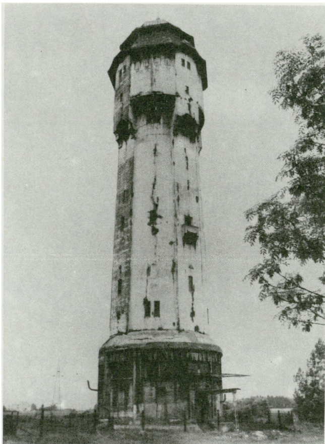
4. Katowice-Borki, ul. Korczaka. Przemysłowa wieża wodna z 1912 r. – dziś odlewnia śrutu
