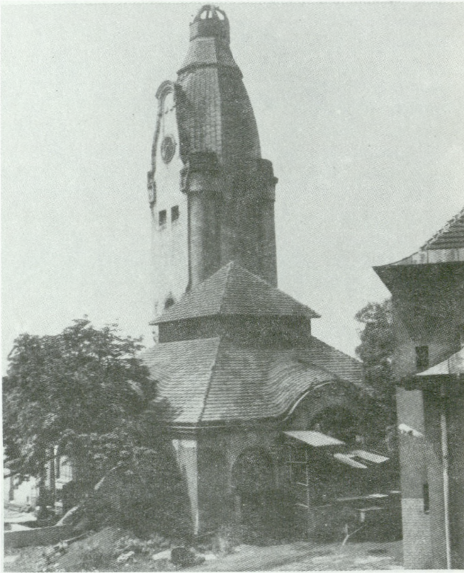
6. Chorzów, ul. Strzelców Bytomskich 11. Szpitalna wieża kominowo-wodna
