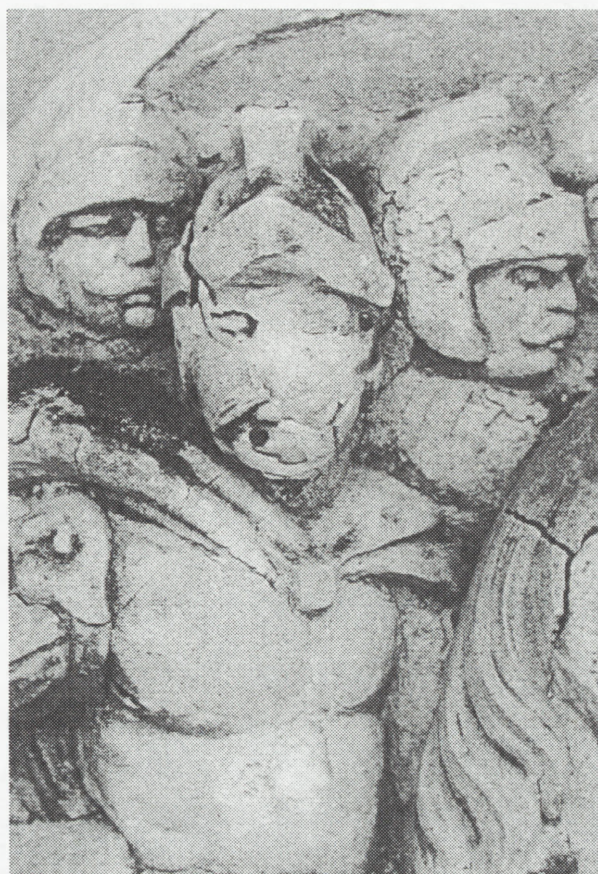
4 i 5. Stan płaskorzeźb z attyki Palacu w Wilanowie w r. 1993. Widoczne ogromne zniszczenia formy rzeźbiarskiej i struktury wapienno-piaskowego narzutu. Fot. P. Mądrach
