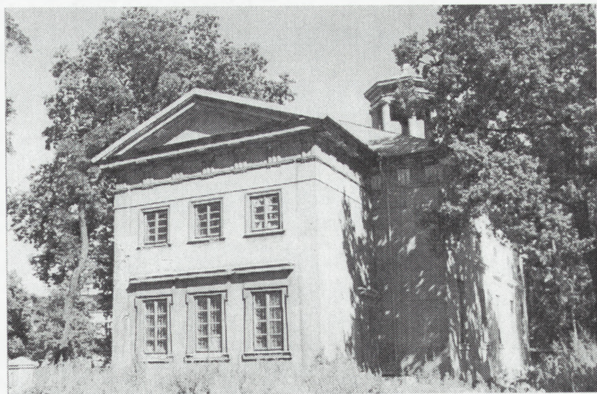
Łowicz — kościół ewangelicki w trakcie remontu
