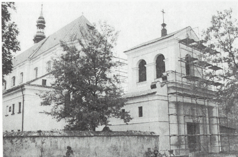
Łowicz — kościół kolegiacki (obecnie katedra) oraz dzwonnica w trakcie remontu
