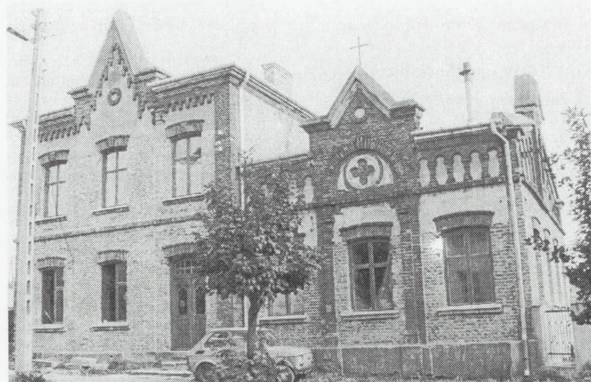
Brzeziny — dawny dom pastora w trakcie remontu
