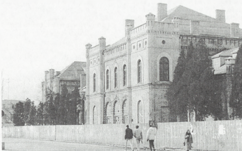
Skierniewice — budynek dworca kolejowego w trakcie remontu
