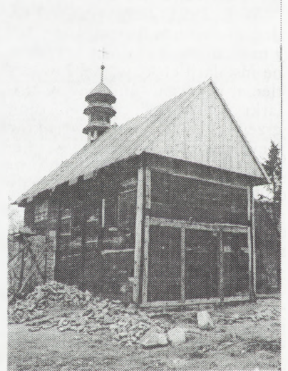
Puszcz Mariańska — kościół parafialny w trakcie remontu
