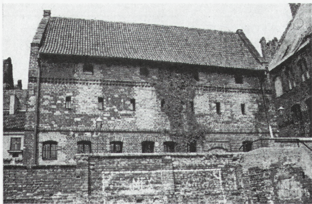
1. Elewacja ceglana po wymianie zniszczonych cegieł i zapraw na nowe. Fot. W. Domasłowski.
