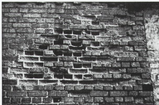
2. Destrukcja cegieł w wyniku zastosowania zapraw do spoinowania o nieodpowiednich właściwościach (duża wytrzymałość mechaniczna, mała porowatość i zdolność kapilarnego przemieszczania wody). Fot. W. Domasłowski
