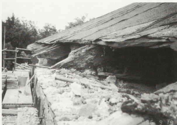
4. Zniszczenie krokwi i dachu więźby pałacu. Stan po demontażu murlaty i przed położeniem wieńca żelbetowego scalającego bryłę budynku
