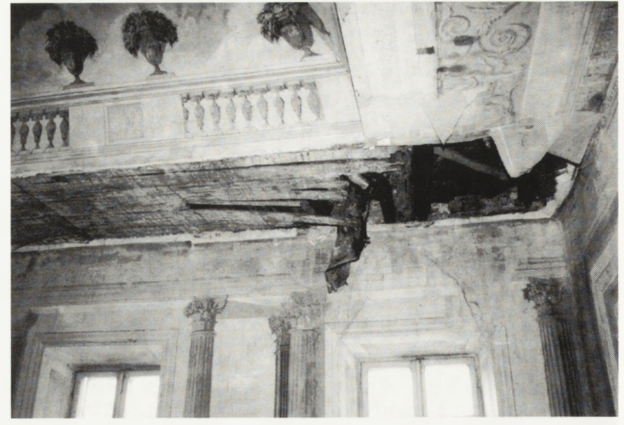
8. Zniszczenie stropu sali balowej pałacu 8. Damaged ceiling in the palace ball room
