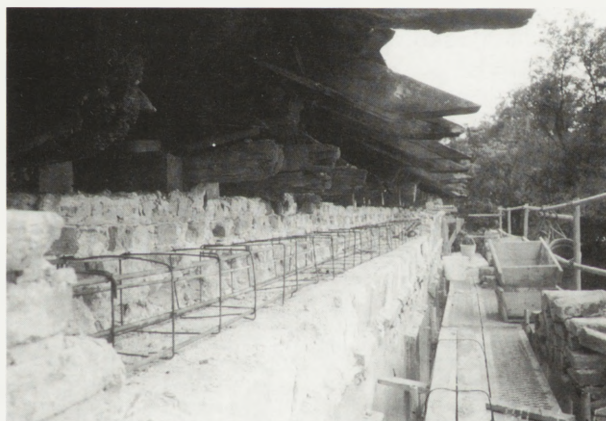
5. Położenie wieńca żelbetowego w poziomie gzymsu poddasza, zastąpił on skorodowaną murlatę drewnianą
