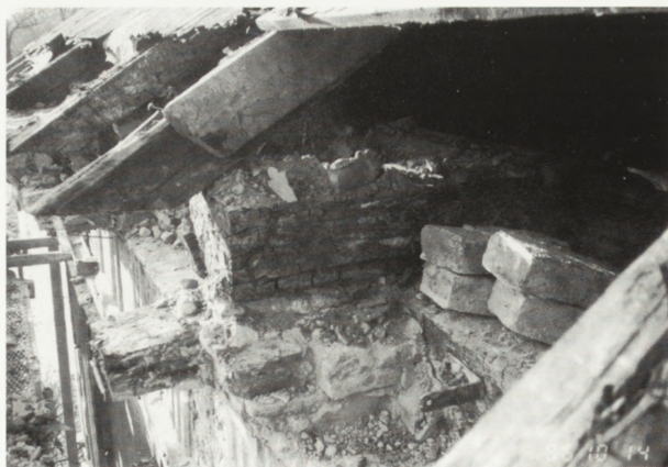
3. Zniszczenie belek stropowych i krokwi w poziomie gzymsu poddasza pałacu
