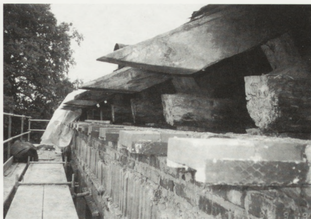
6. Gzyms poddasza po przemurowaniu i zalaniu zbrojenia betonem
