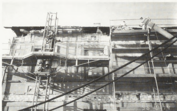
2. Prace przy rozbiórce starego gzymsu poddasza
