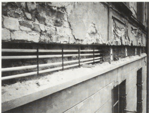
12. Betonowanie opaski żelbetowej wstępnie sprężonej
