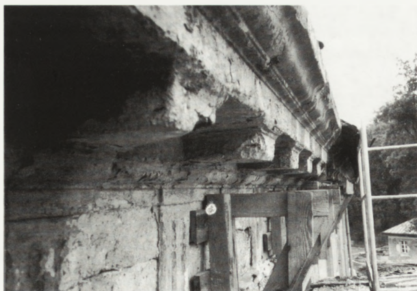
1. Gzyms poddasza, widoczna erozja tynku. Wszystkie fot. M. Karalus 1. Attic cornice, with visible plaster erosion. All photos by M. Karalus
