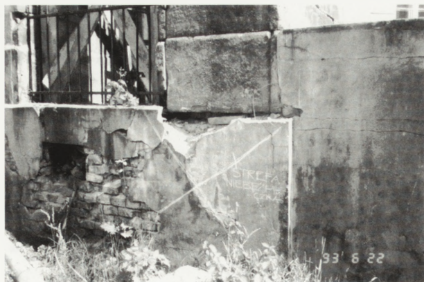
8. Destrukcja ściany policzkowej i podstawy pod kolumnami portyku. Fot. S. Zborowski
