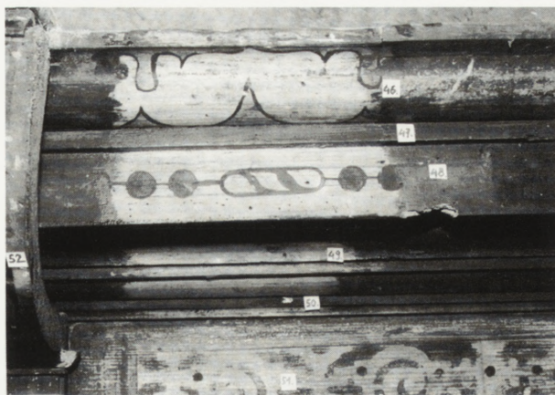
3. Odkrywki na gzymsie wieńczącym — pierwotny ornament na białej zaprawie
