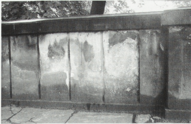
2. Mur ogrodzenia od strony ulicy Chopina. Powierzchniowe, intensywne łuszczenie się piaskowca. Fot. P. Gutowski
