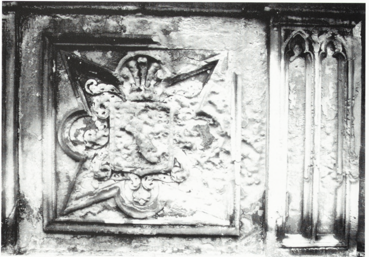
6. Mauzoleum Potockich, stan destrukcji tablicy z herbem „Szreniawa” w 1977 r. Fot. A. Koss
