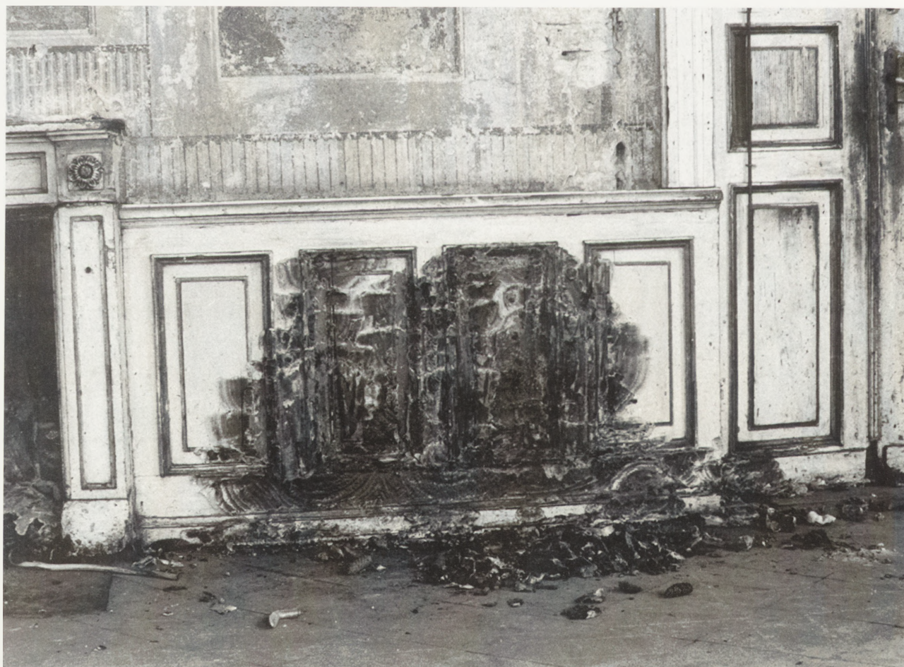
7. Obiekt zaatakowany przez grzyby. Fot. A. Mazur
