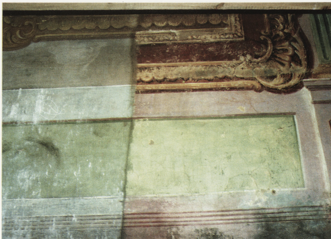
5. Usuwanie przemalowań. Z prawej strony widoczny fragment odsłoniętej oryginalnej kompozycji. Fot. A. Mazur
