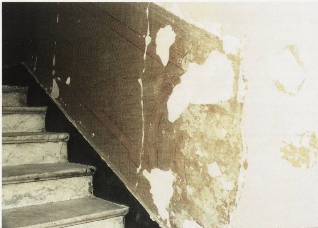
4. Usuwanie nawarstwień farb olejnych (lamperia). Widoczne odkryte ciemniejsze partie mazerunków olejnych. Fot. P. Jakubowski
