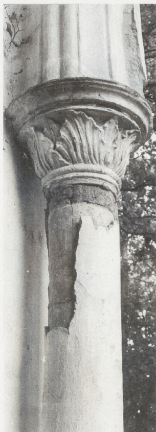
13. Brama mauretańska: a — fragment kolumny z widocznym spod odszpejonego tynku trzonem ceramicznym; b — kolumna, stan przed konserwacją; c — kolumna, stan po konserwacji. Fot. A. Koss
