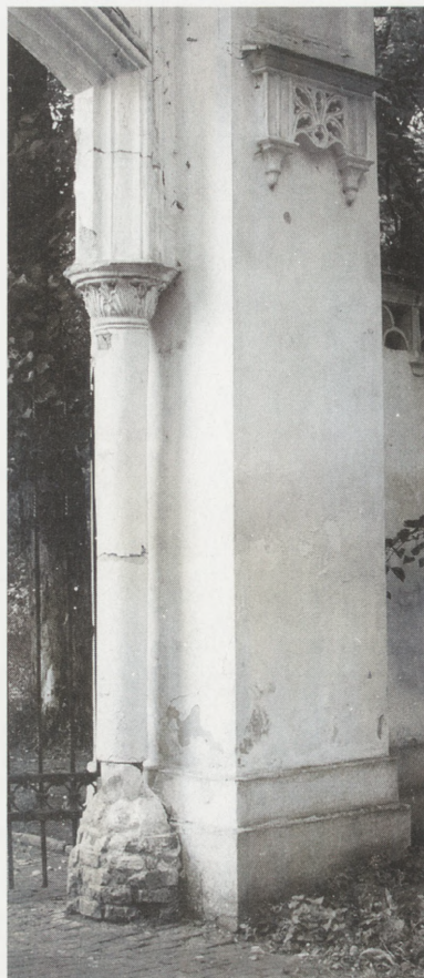
13. Brama mauretańska: a — fragment kolumny z widocznym spod odszpejonego tynku trzonem ceramicznym; b — kolumna, stan przed konserwacją; c — kolumna, stan po konserwacji. Fot. A. Koss
