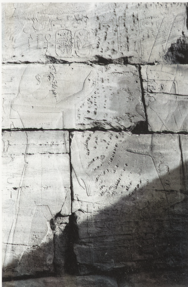
9. Uszkodzone przez obrostkę ( Chalicodoma siculum Risso) ściany z piaskowca pokryte płaskorzeźbami (świątynia w Luksorze)
