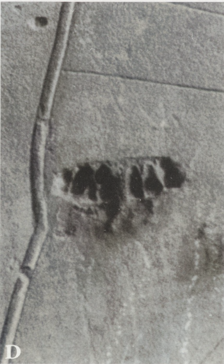
8. Poszczególne fazy oszpecania (A, B, C) i niszczenia (D, E) piaskowca w monumentalnych budowlach z czasów faraonów w Górnym Egipcie, spowodowane przez obrostkę Chalicodoma siculum (Risso). A — opuszczone gniazdo z widocznymi wylotowymi (sklepienie „sali na barkę” świątyni królowej Hatszepsut w Deir el-Bahari), B — uszkodzone gniazdo z widocznymi komorami larw (również świątynia królowej Hatszepsut), C — świeże ślady po usuniętym gnieździe (jak wyżej), D — stosunkowo świeży „wżer” w kamieniu (świątynia w Luksorze), E — stare „wżery” w kamieniu (świątynia w Luksorze)
