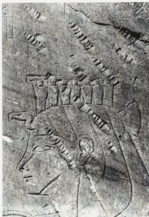
9. Uszkodzone przez obrostkę ( Chalicodoma siculum Risso) ściany z piaskowca pokryte płaskorzeźbami (świątynia w Luksorze)
