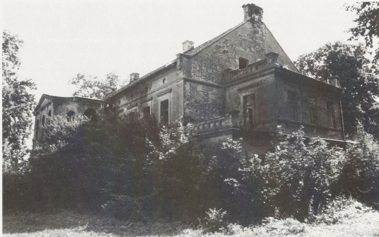
5. Dwór w Osieku koło Kościana. Fot. T. Łuczak, 1997 r.
