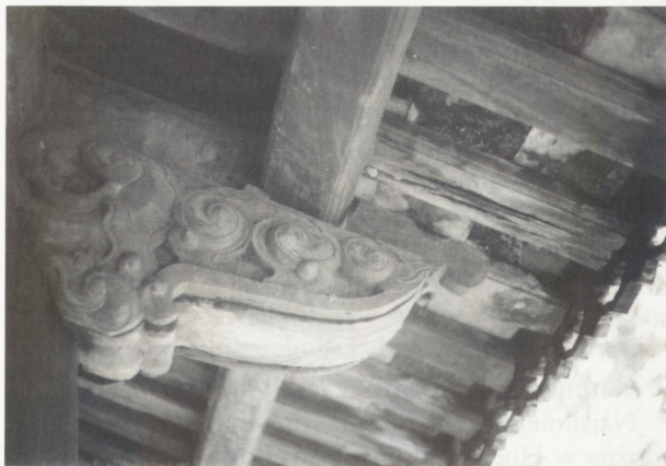
15. Okap bez obróbki blacharskiej, która łatwo dalaby się ukryć za ozdobną listwą, to jedna z podstawowych przyczyn biokorozji dachów (świątynia Tre Mieu)
