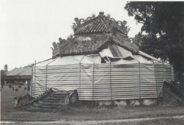
10. Namiot osłaniający przed opadami wnętrze niewielkiego pawilonu w trakcie prac konserwatorskich
