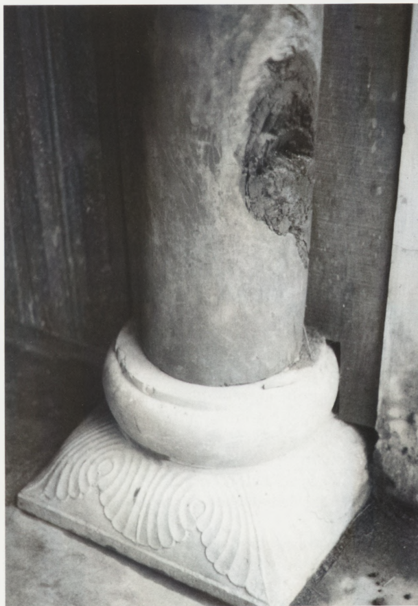
14. Drewniana kolumna z bocznym murszem ubudowana w ramach poprzedniej renowacji w pawilonie Ta Vu — przykład kłopotów z drewnem odpowiedniej jakości w dzisiejszym Wietnamie
