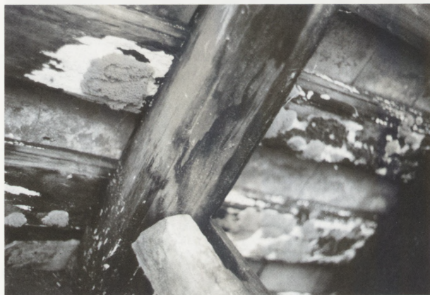
11. Liczne owocniki lokalnego szczepu stroczka domowego ( Serpula lacrymans ) na drewnie konstrukcji dachu małego budynku koło świątyni The Mieu
