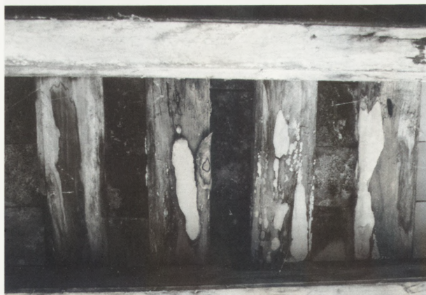
12. Liczne owocniki grzyba Poria medullaris na okapowej części dachu małego budynku koło świątyni The Mieu
