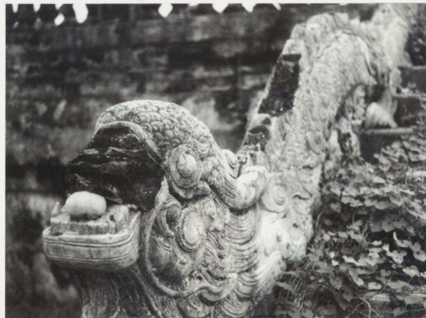
8. Uszkodzenia betonowych rzeźb smoków obramowujących schody pawilonu Lau Kien Trung
