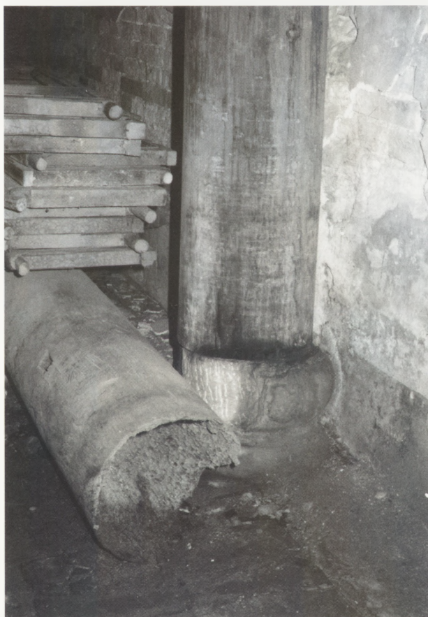
13. Stara, drewniana kolumna w świątyni The Mieu wydrążona przez termity ziemne
