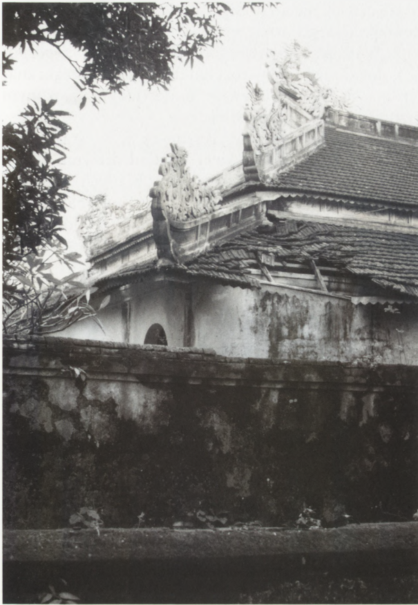
9. Uszkodzenia dachów w wyniku działań wojennych i powojennych zaniedbań to jedna z najpoważniejszych przyczyn biodegradacji budynków (świątynia Thai Mieu)
