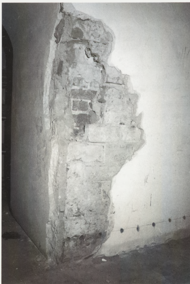
4. Ściana wewnętrzna, równoległa do zewnętrznej, w piwnicy przy ul. Jezuickiej 1/3 w Warszawie. Widoczne zawilgocenia muru do wysokości jedynie kilku cm nad posadzką oraz próba wykonania poziomej przepony hydrofobowej metodą termoiniekcji. Fot. I. Sawosko
