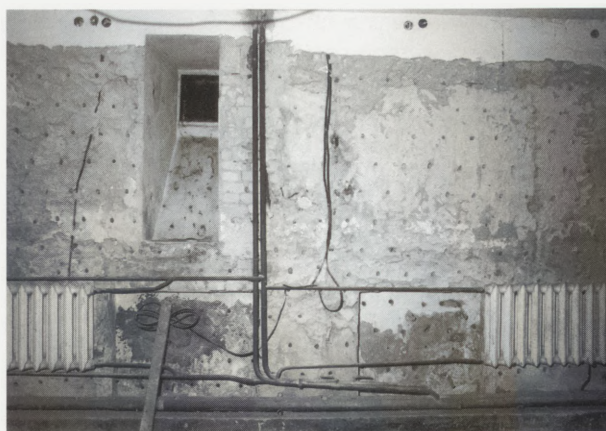
3. Ściana zewnętrzna piwnicy budynku przy ul. Jezuickiej 1/3 w Warszawie — widok od strony pomieszczenia. Próba wykonania poziomej i pionowej przepony hydrofobowej metodą termoiniekcji. Fot. I. Sawosko
