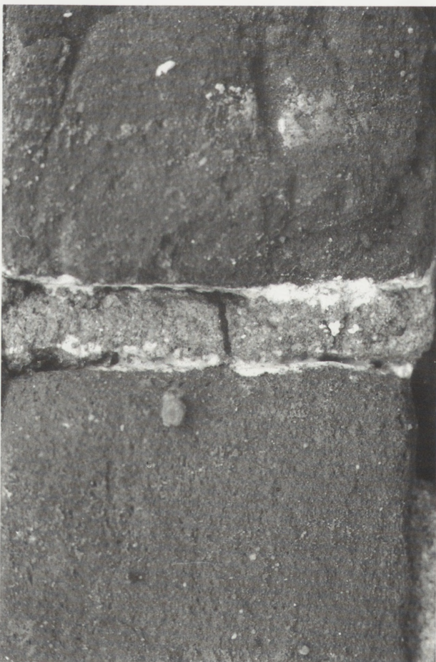
3. Wycieki zaczynu w stykach spoiny z ceglami. Fot. T. Kowalski
