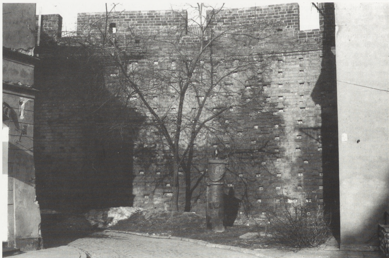
10. Mur obronny widziany od strony Starego Miasta po wykonaniu prac wzmacniających. W trakcie naprawy powierzchni muru gniazda kryjące kotwy zostały zamurowane płytkami ceglanyimi. Fot. T. Kowalski
