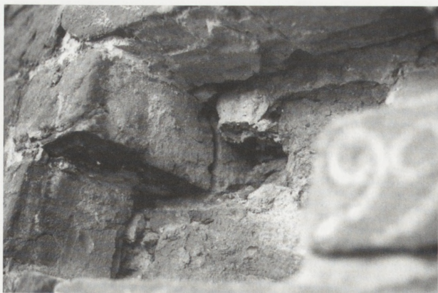
2. Odspojenie licowej warstwy muru grubości 0,5 cegły na odcinku wychylonym, od strony międzymurza, na wysokości ok. 300 cm nad powierzchnią terenu. Stan z 1991 r. Fot. T. Kowalski.
