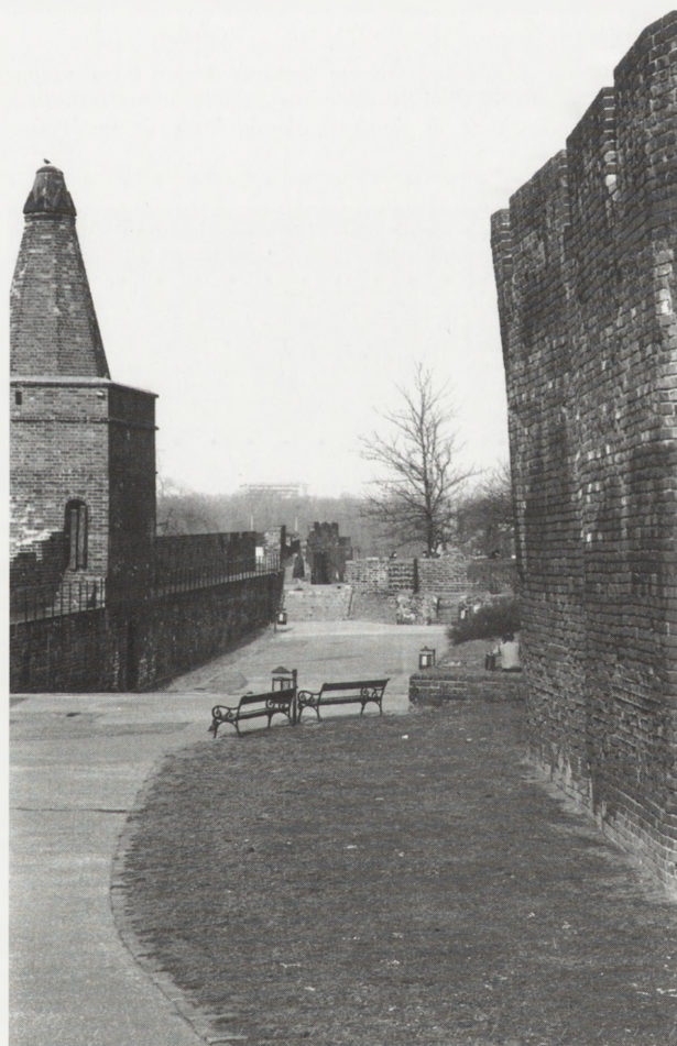
1. Widok z międzymurza na odcinek wychylony wewnętrznego obwodu murów obronnych (od strony południowo-zachodniej). Z lewej strony Baszta Prochowa. Stan z 2000 r. Fot. S. Maszewski
