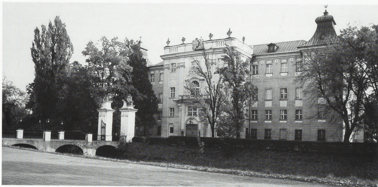
Rydzyna, zamek po konserwacji — elewacja północna. Fot. A. Łuczak
