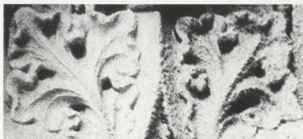
2. Metody czyszczenia powierzchni piaskowca w praktyce: lewa część czyszczona laserem, prawa — metodą delikatnego piaskowania w strumieniu wody
