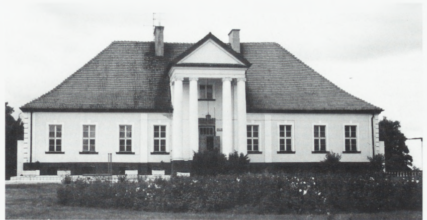
Srebrna Góra. Dwór — elewacja frontowa. Fot. T. Łuczak, 1996
