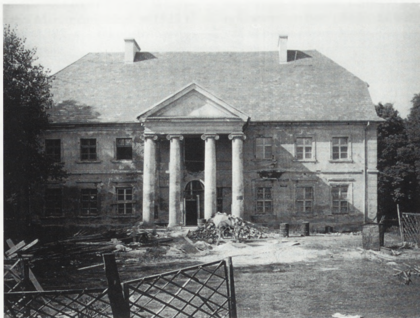
Kołaczkowo. Dwór — elewacja frontowa w trakcie remontu. Fot. E. Linette, 1969, z Archiwum PP PKZ
