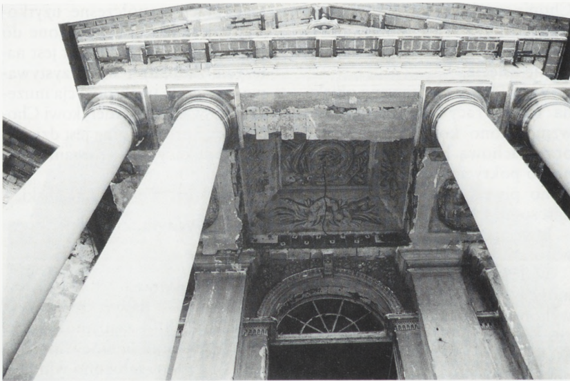
Dobrzyca. Fryz tympanonu pałacu wzmocniony metalowym rusztem. Fot. A. Jabłońska, 2001
