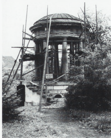
Dobrzyca. Pawilon ogrodowy ( monopter ), reszta zabezpieczona — zrekonstruowane schody i wejście do piwnicy. Fot. A. Jabłońska, 2001
