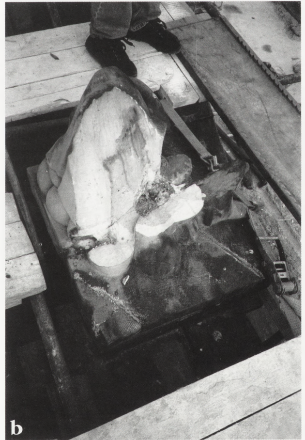
3. Rzeźba Ateny: a — demontaż górnego fragmentu rzeźby z rozsądzonej podstawy posadowionej na impoście południowego narożnika tympanonu. Fot. W. Procyk; b — popękana w wyniku korozji stalowego łącznika dolna część i podstawa rzeźby przed demontażem. Fot. W. Procyk 3. Sculpture of Athene: a — disassembly of the upper fragment of the sculpture from the burst base installed on the impost of the southern tympanum corner. Photo: W. Procyk; b — the lower part and the base of the sculpture cracked as a result of the corrosion of the steel connector prior to disassembly. Photo: W. Procyk
