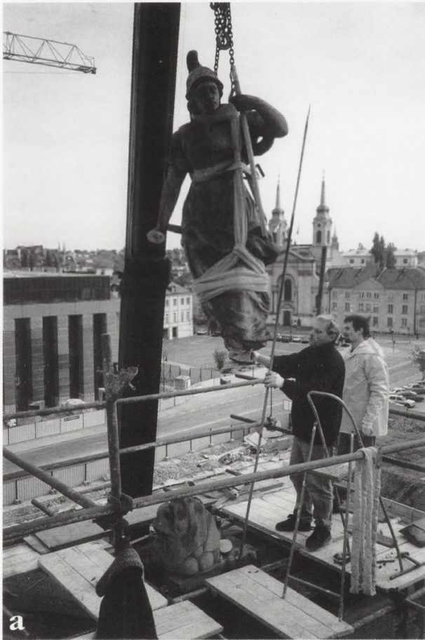
3. Rzeźba Ateny: a — demontaż górnego fragmentu rzeźby z rozsądzonej podstawy posadowionej na impoście południowego narożnika tympanonu. Fot. W. Procyk; b — popękana w wyniku korozji stalowego łącznika dolna część i podstawa rzeźby przed demontażem. Fot. W. Procyk 3. Sculpture of Athene: a — disassembly of the upper fragment of the sculpture from the burst base installed on the impost of the southern tympanum corner. Photo: W. Procyk; b — the lower part and the base of the sculpture cracked as a result of the corrosion of the steel connector prior to disassembly. Photo: W. Procyk
