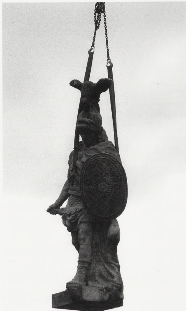
8. Demontaż rzeźby Marka Waleriusza Corwinusa ze zwieńczenia tympanonu i podniebna podróż kilkuntonowej postaci nad dachami palacu w samopoziomujących zawieszach. Fot. W. Procyk
