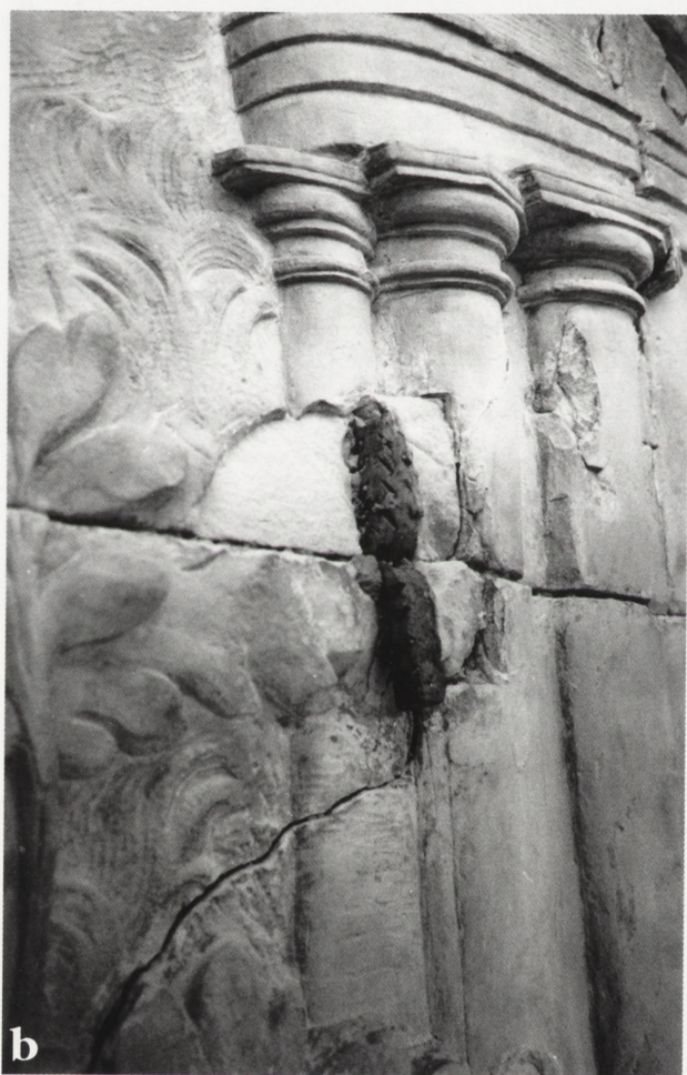
9. Stalowe, ręcznie kute klamry z zachowanej, oryginalnej części tympanonu: a — wewnętrzna spinająca trzy bloki płaskorzeźby w środkowej części portyku, usztywniona punktowo „zalewką” z ołowiu (odsłonięta w trakcie wykonywania gniazda pod flek); b — końcówki klamry zewnętrznej stabilizującej bloki z płaskorzeźbioną kolumnadą świątyni Westy. Fot. W. Procyk
