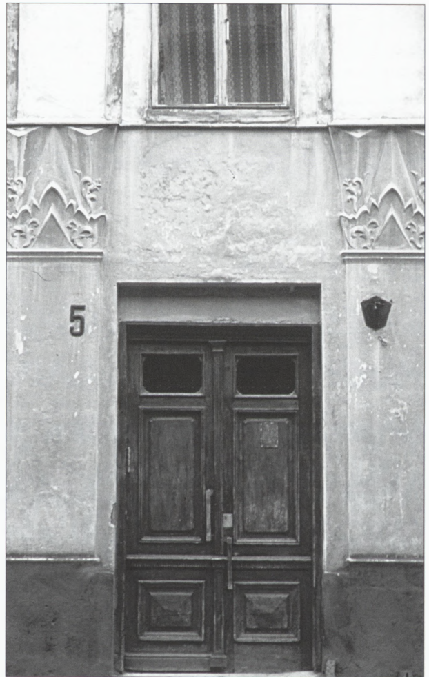
7. Lwów, kamienica, ul. Boimów, fasada po odnowieniu uzupełniona o współczesne elementy (dekoracja w stylu art deco, po 1925 r.), stan współczesny – dolny fragment fasady. Fot. J. Lewicki 2001
