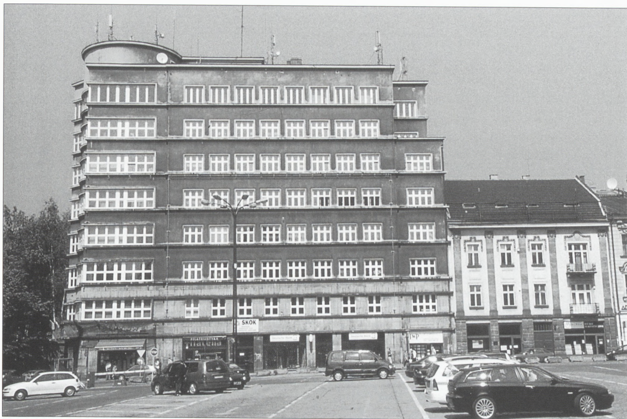
11. Kraków, róg placu Szczepańskiego i ul. Reformackiej. Przykład międzywojennej współczesnej realizacji w otoczeniu zabytkowym (budynek Komunalnej Kasy Oszczędności, arch. Fryderyk Tadanier i Stefan Strojek, realizacja 1936). Budynek dominujący nad otoczeniem spowodował protesty konserwatorów. Stan współczesny. Fot. J. Lewicki 2000
