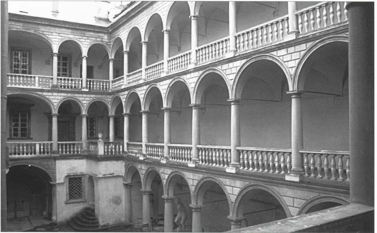
3 B. Lwów, kamienica Królewska (Rynek 6), dziedziniec. Stan obecny po zbudowaniu krążganków w okresie międzywojennym, proj. Ludomil Gyurkovich. Fot. J. Lewicki 2000
