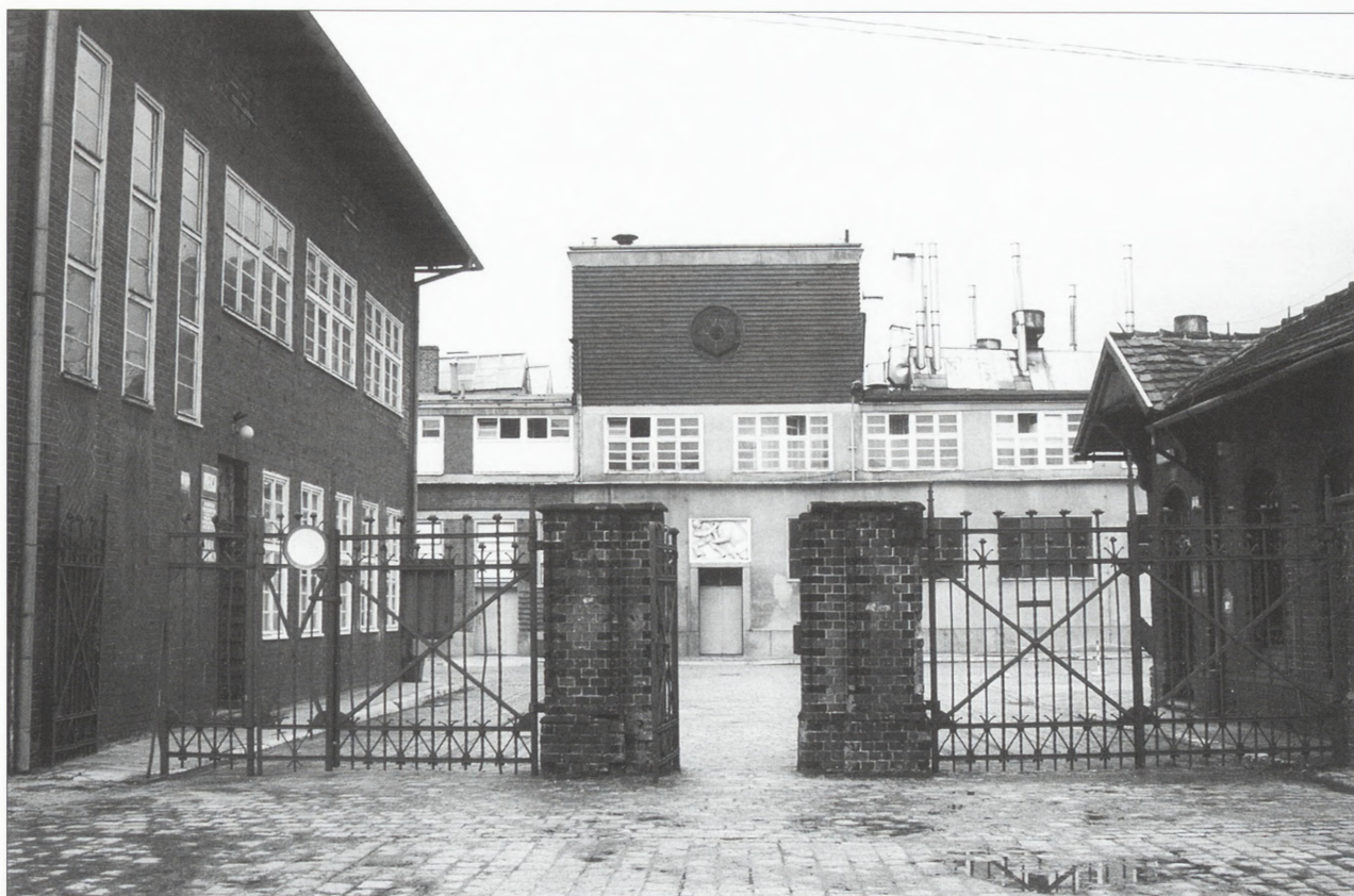
10. Rzeźnia i targ zwierząt rzeźnych we Wrocławiu. Zabudowa z okresu międzywojennego, widok nowej ubojni trzody chlewnej i kantyny. Stan z czerwca 1999 r.
