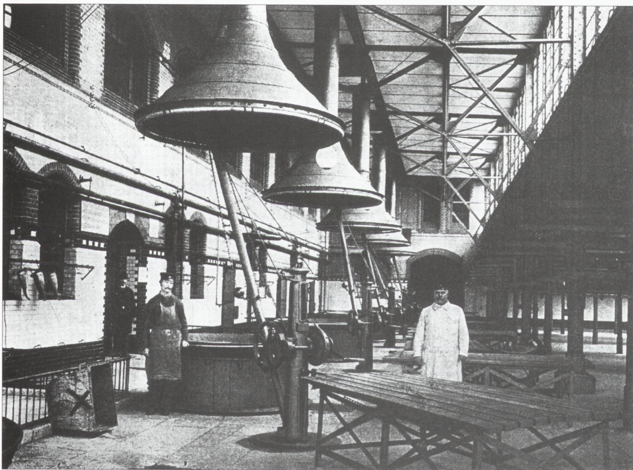
12. Rzeźnia i targ zwierząt rzeźnych we Wrocławiu. Wnętrze pomieszczenia z kadziami do oparzania świń. Repr. z Schlachthof und Viehmarkt zu Breslau
