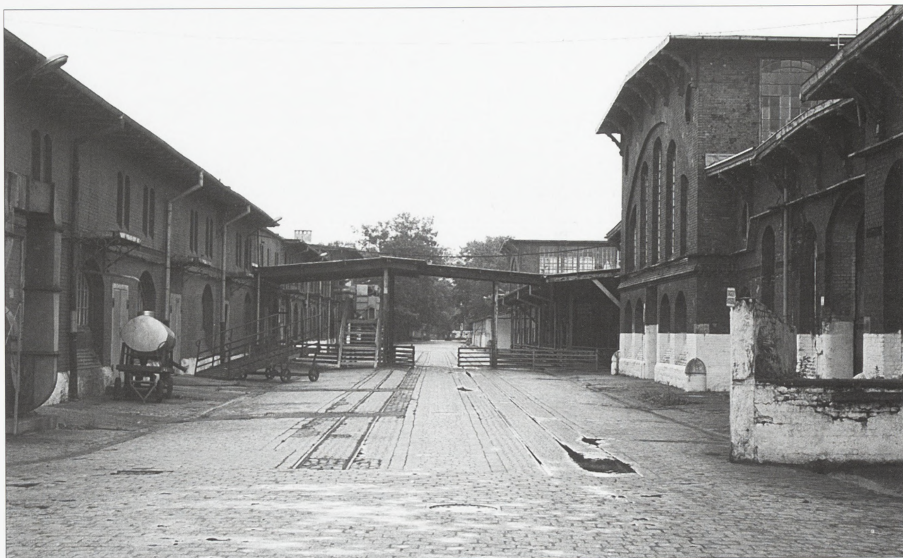
7. Rzeźnia i targ zwierząt rzeźnych we Wrocławiu. Droga między dawnymi halami targowymi i budynkami stajni przedubojowych. Stan z czerwca 1999 r.
