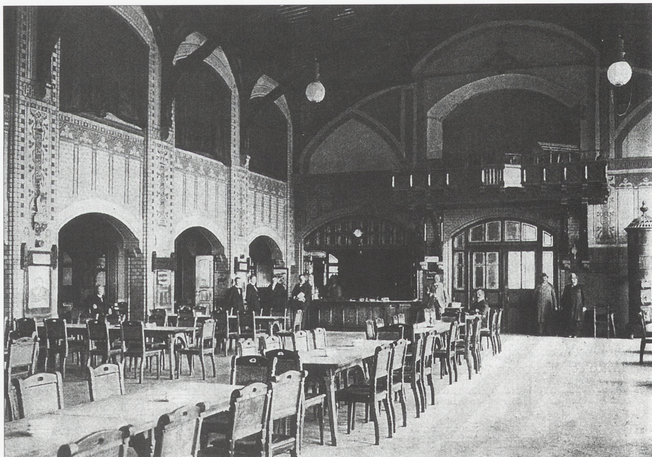
9. Rzeźnia i targ zwierząt rzeźnych we Wrocławiu. Wnętrze budynku giełdy. Repr. z Schlachthof und Viehmarkt zu Breslau
