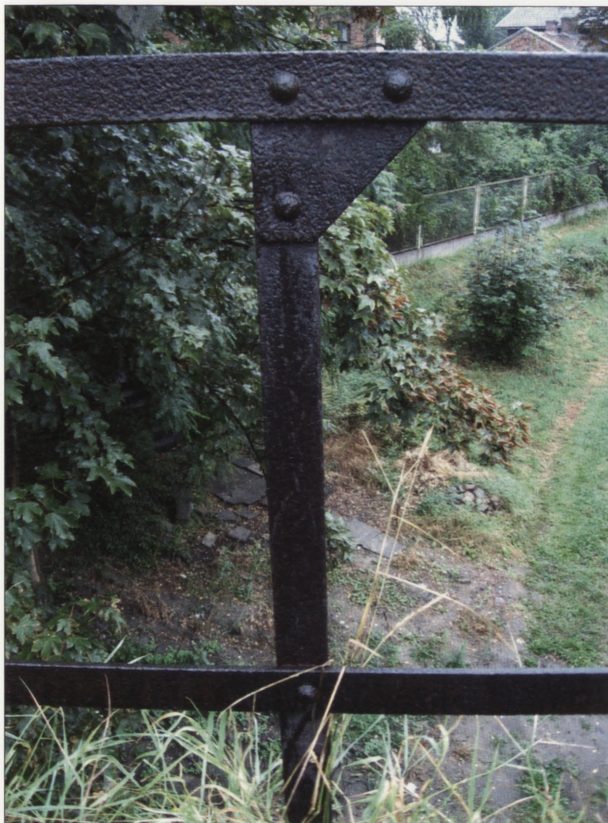
7. Słupek nitowanej bariery. 7. Riveted barrier post.
