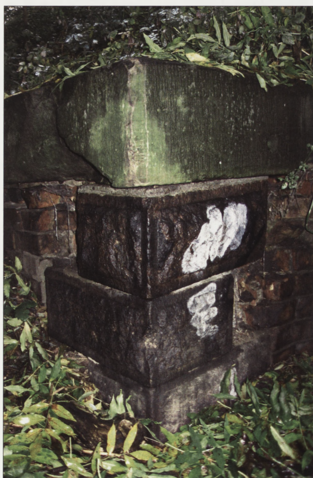
3. Licowanie zakończenia muru oporowego. 3. Facing on the end of a retaining wall.
