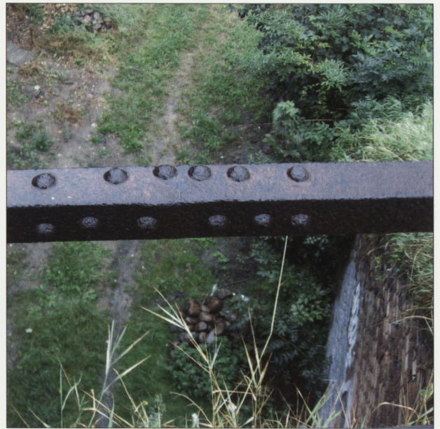
8. Szef nitowy elementów konstrukcyjnych bariery. 8. Riveted joint of barrier construction elements.
