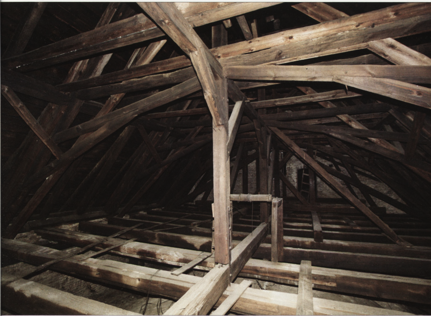
12. Raszyn, kościół pw. św. Anny, widok konstrukcji więźby nad nawą, XVII-XVIII w.
