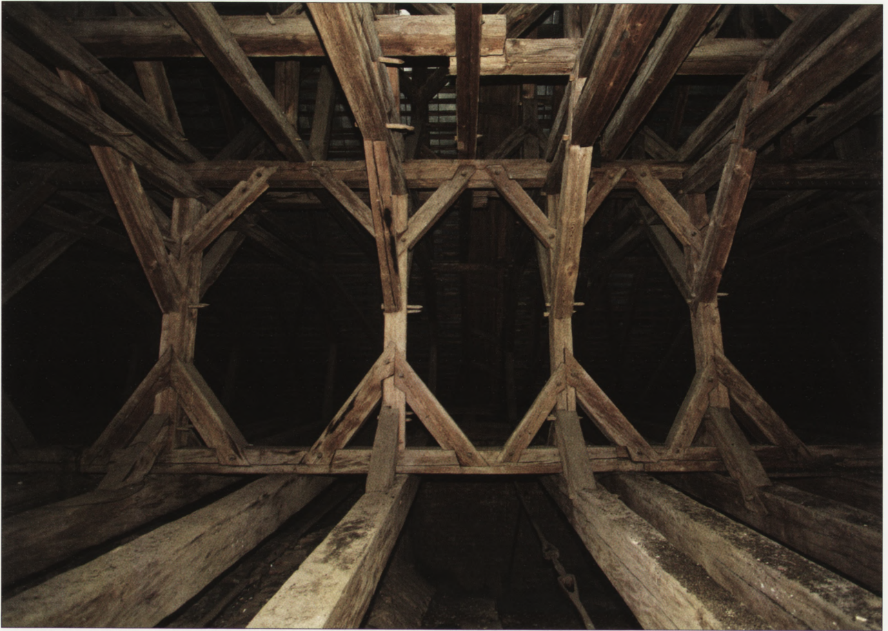
16. Głuchów, kościół pw. św. Wacława, widok centralnej ramy stolcowej więźby nad nawą i prezbiterium, 2. poł. XVIII w. 16. Głuchów, church of St. Wacław (Wenceslas), view of the central frame of the queen-post rafter framing above the nave and the presbytery, second half of the eighteenth century.
