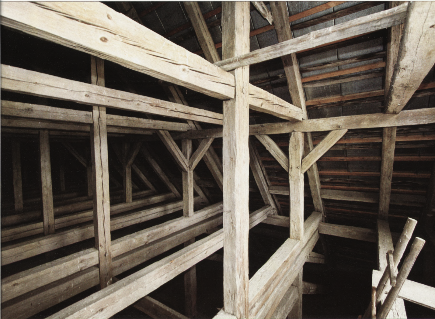
8. Lipowiec Kościelny, kościół pw. św. Anny, widok konstrukcji więźby nad nawą, początek XIX w.
