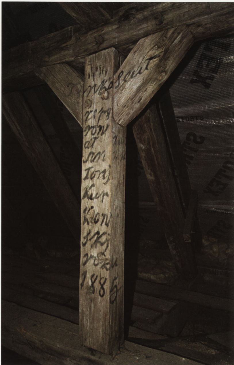
1. Ratowo, kościół pw. św. Antoniego, inskrypcja na stolem konstrukcji więźby nad nawą. Wszystkie fot., rys. i oprac. M. Warchol.
