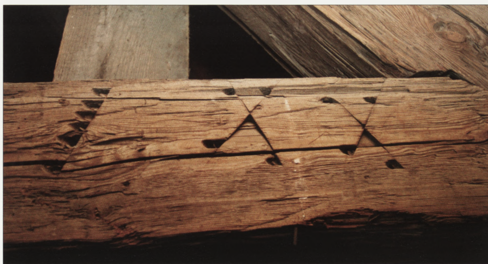
14. Przasnysz, kościół pobernardyński pw. św. św. Jakuba i Anny, ciesielskie znaki montażowe na elemencie konstrukcji więźby nad nawą.
