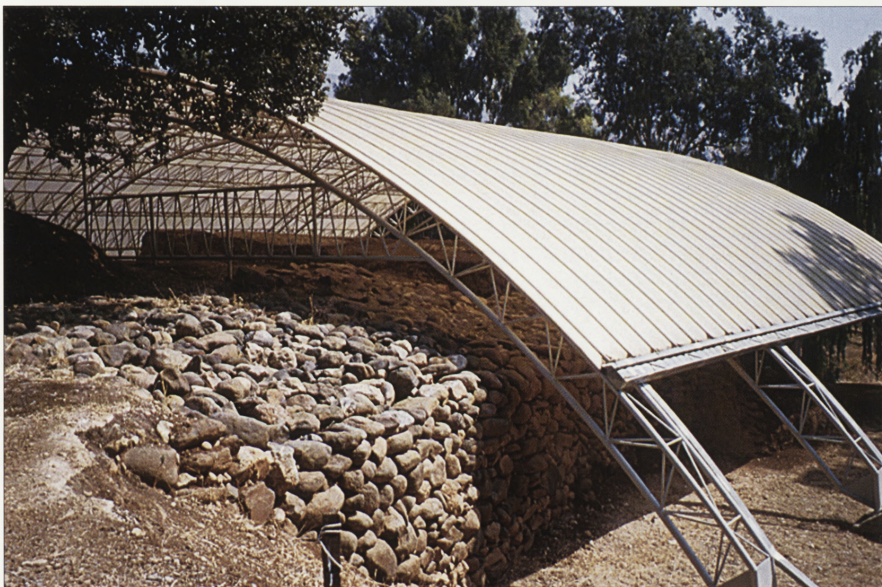
1. Zadaszenie ochronne nad konstrukcjami z epoki brązu w Tel Dan w Izraelu. Fot. ICCROM. 1. Protective roof over structures from the Bronze Age in Tel Dan, Israel. Photo: ICCROM.
