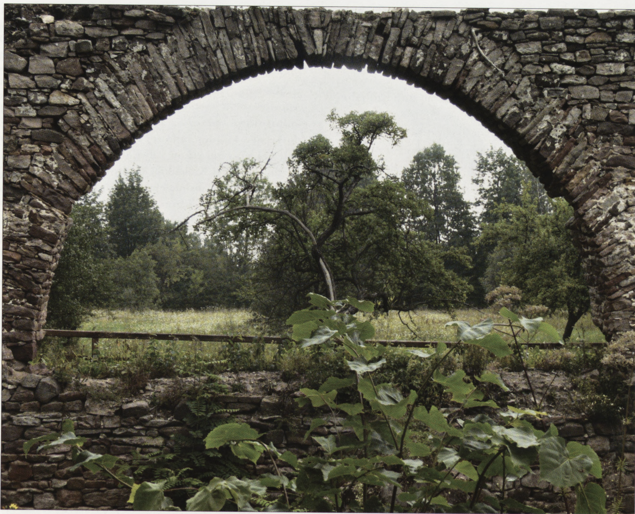
7. Ruiny Zakładu Wielkopicowego w Bobrzy, ruiny węgielni (skład na węgiel drzewny). 7. Ruins of the Blast Furnace Plant in Bobrza, ruins of the wood coal store.
