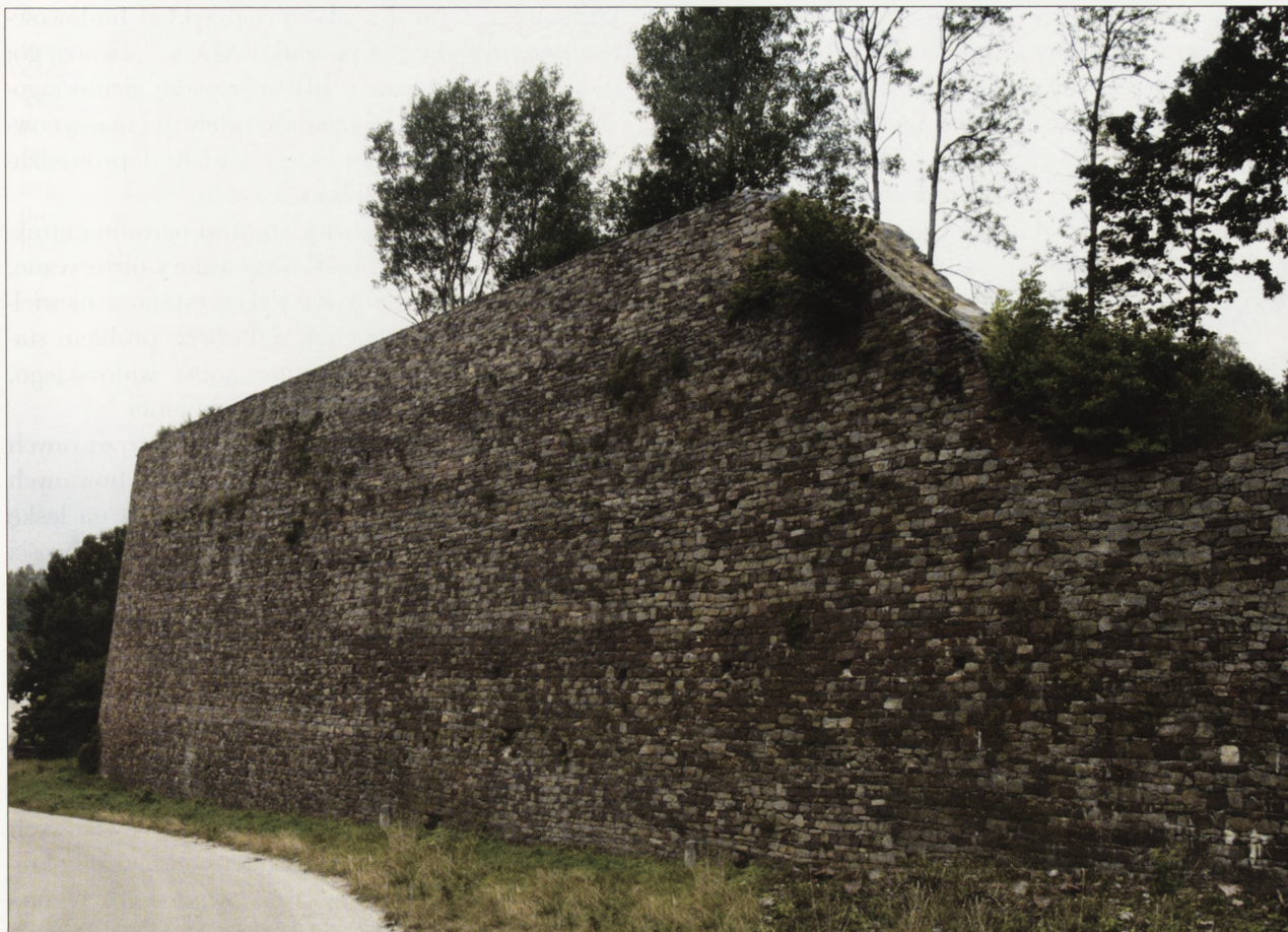
5. Ruiny Zakładu Wielkopieczowego w Bobrzy, zachowany mur oporowy długości 500 m. 5. Ruins of the Blast Furnace Plant in Bobrza – the retaining wall with a length of 500 m.
