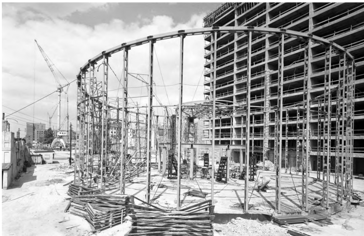
Budowa Rotundy PKO w Warszawie w latach 1962–1963. Z prawej widoczny fragment budowanego gmachu Uniwersalu (Narodowe Archiwum Cyfrowe)
