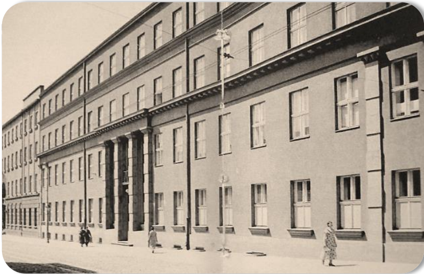
Gmach dowództwa OK IV przy ul. 11 Listopada 81 – zdjęcie z połowy lat trzydziestych (J. Oleńderek, Łódzki modernizm i inne nurty przedwojennego budownictwa , Łódź 2011, s. 30–31)
