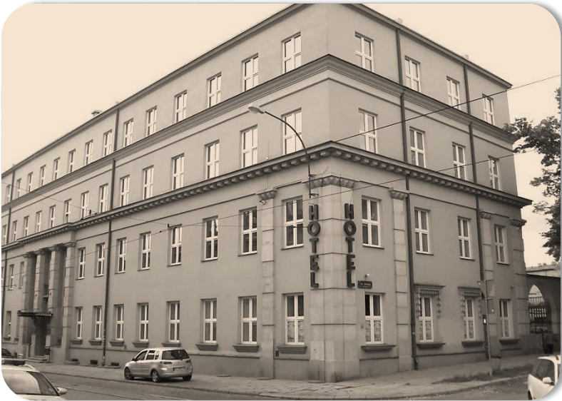
Gmach przy ul. Legionów 81 (obecnie Hotel Reymont) – widok od strony ulicy (fot. W. Jarno z 2014 r.)
