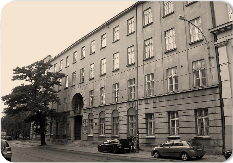
Budynek dawnego dowództwa Łódzkiego OW przy ul. Legionów 83 (fot. W. Jarno z 2014 r.)
