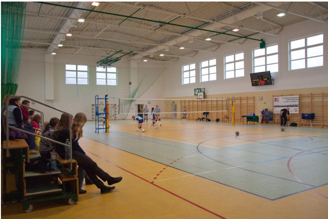
Rycina 18. Nowa hala sportowa w Będzinie-Ksawerze
