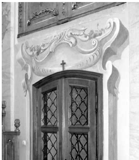
Fot. 20. Przemyśl, ściana nawy kościoła Benedyktynów św. Trójcy, Stanisław Stroiński, architektura iluzjonistyczna, fresk, 1773-1777, fot. M. Ludera
