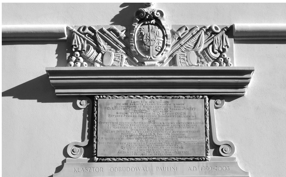
Il. 2. Włodawa, południowe skrzydło klasztoru Paulinów, tablica fundacyjna i kartusz herbowy ponad rekonstruowanym portalem (pierwotnie na fasadzie niezachowanej kaplicy przyklasztornej?), 1717, fot. M. Ludera.
