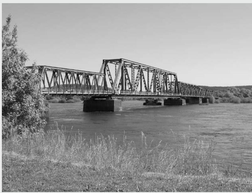
Ryc. 5. Most kolejowy na Odrze koło Siekierok podczas powodzi; fot. R. Michalak 06.2010
