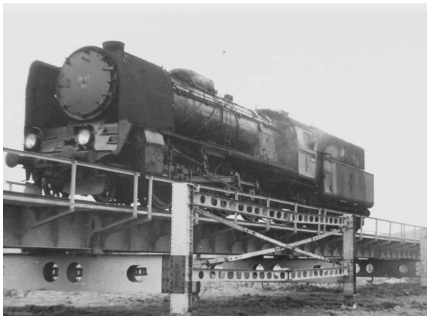
Ryc. 10. Siekierki, ćwiczenia „Bariera 79”, próbny przejazd parowozu PKP PT 47; fot. płk J.R. Sz wajka
