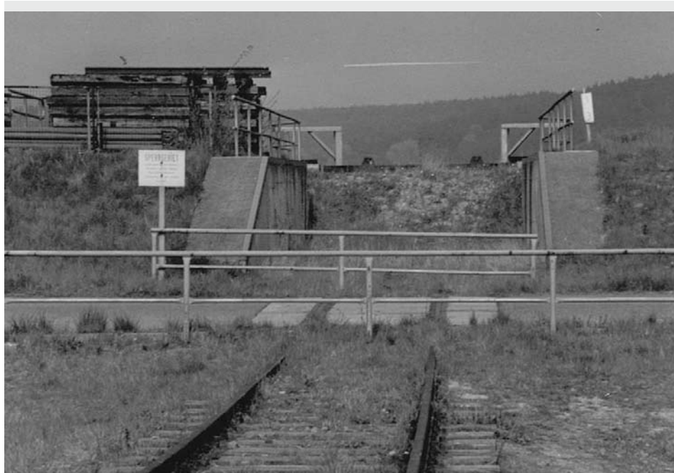
Ryc. 6. Przejazd przez wał przeciwpowodziowy po stronie niemieckiej zbudowany w latach 1977 – 78; fot. Peter Bley 04.1991
