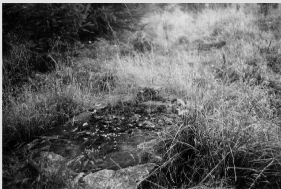
Fot. nr 9 – Widok fundamentu, na którym stała wieża wartownicza. Źródło: AIPN Sz, 419/15, s. 60.
