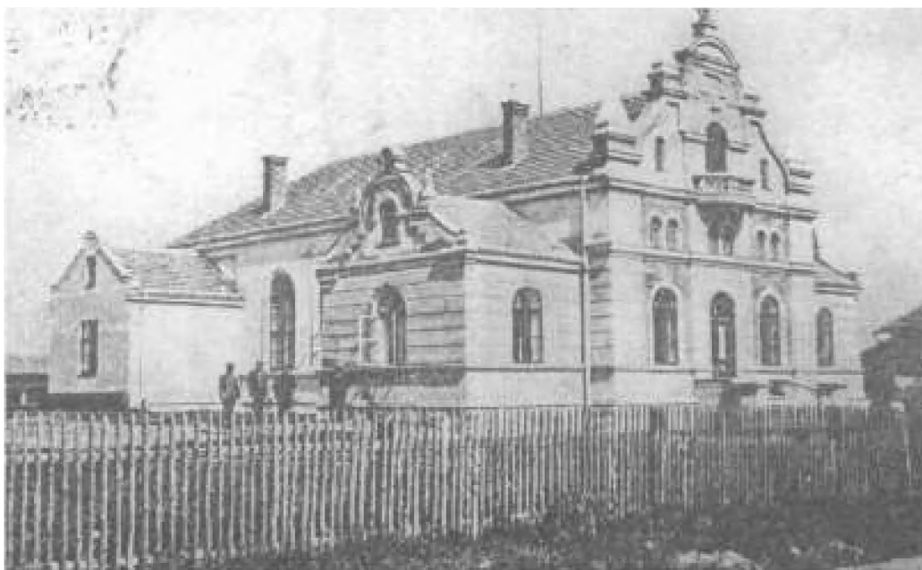
13. Budynek T-stwa Gimnastycznego "Sokół" z 1900 r.
