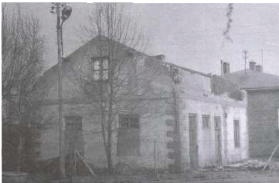
Budynek kałalnej rzeźni drobiu podczas rozbiórki w 1978r., w którym mieszkał dziadek z babcią. W tle nowy dom, w którym obecnie mieszkamy.
