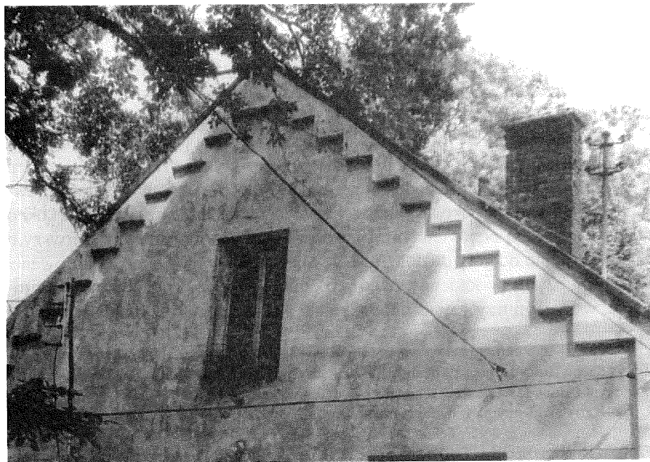
Szczyt oficyny z dekoracją schodkową (obecnie).
