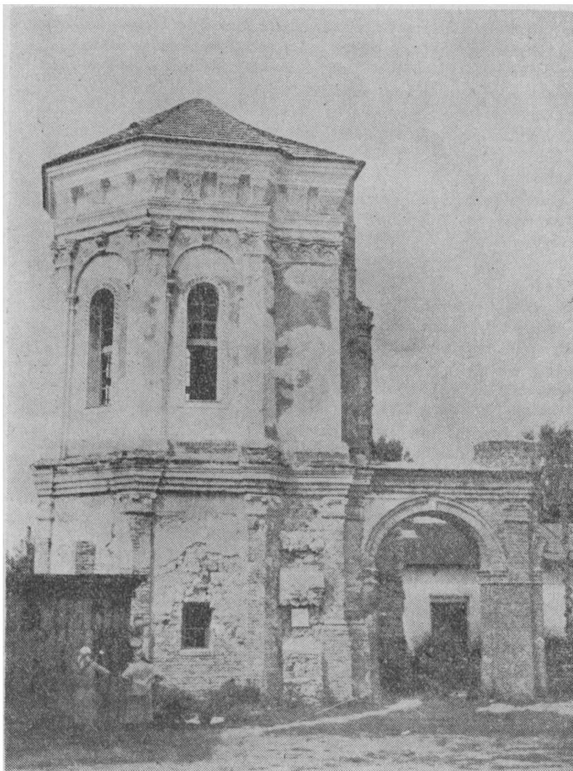
Dąbrowica. Fot. w 1959 r. po robotach zabezpieczających
