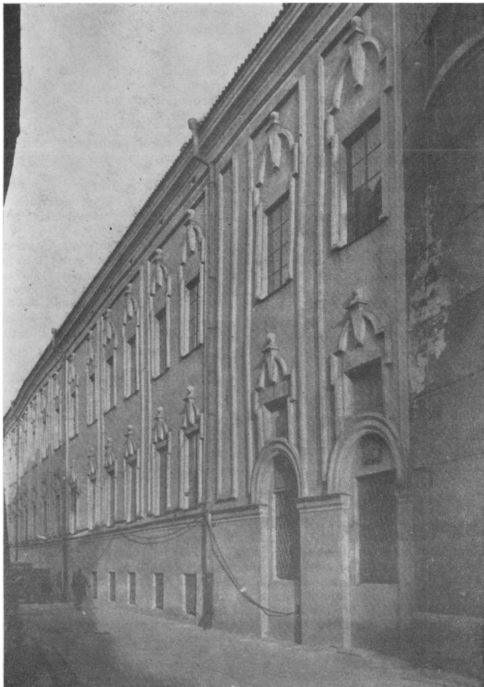
Elewacja skrzydła północnego od ulicy Trybunalskiej po odbudowie (Fot. J. Szandomirski, 1966)
