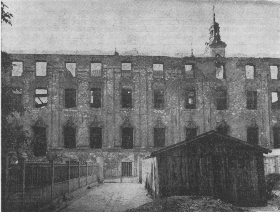
Elewacja skrzydła północnego od ulicy Trybunalskiej przed odbudową (Fot. J. Szandomirski, 1958)
