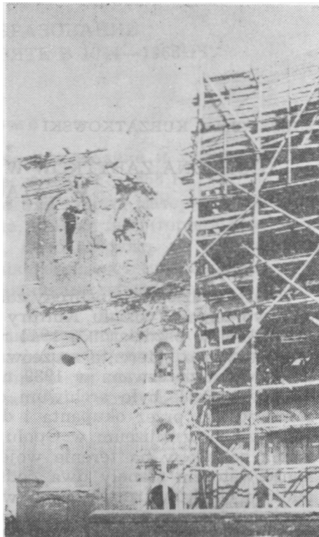
Kościół w Gołębie w trakcie odbudowy w 1948 r.
