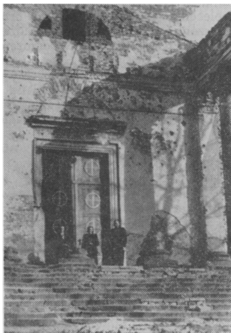
Elewacja frontowa kościoła w Puławach w 1945 r.
