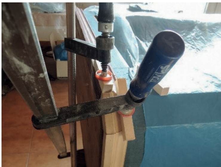
Fot. 7. Gzyms w trakcie konserwacji
