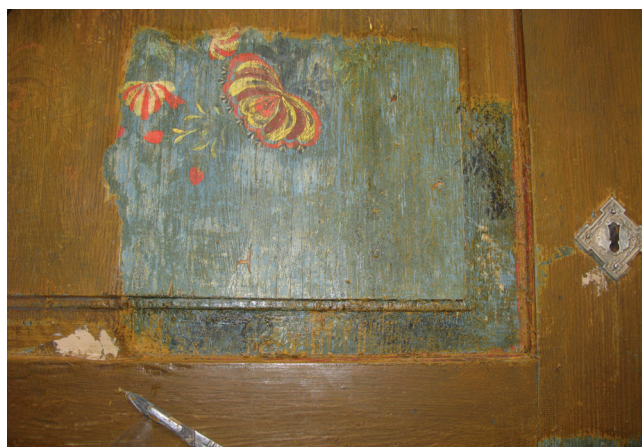
Fot. 4. Stan zachowania polichromii florystycznych na drzwiach
