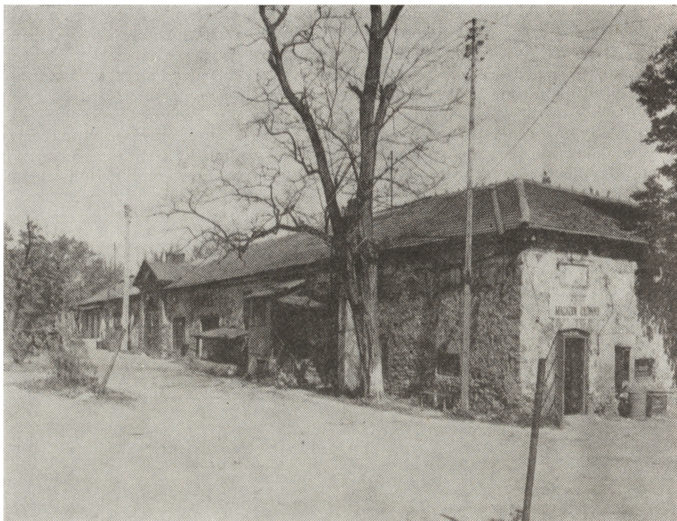
Ryc. 9. Browar, elewacja południowa
