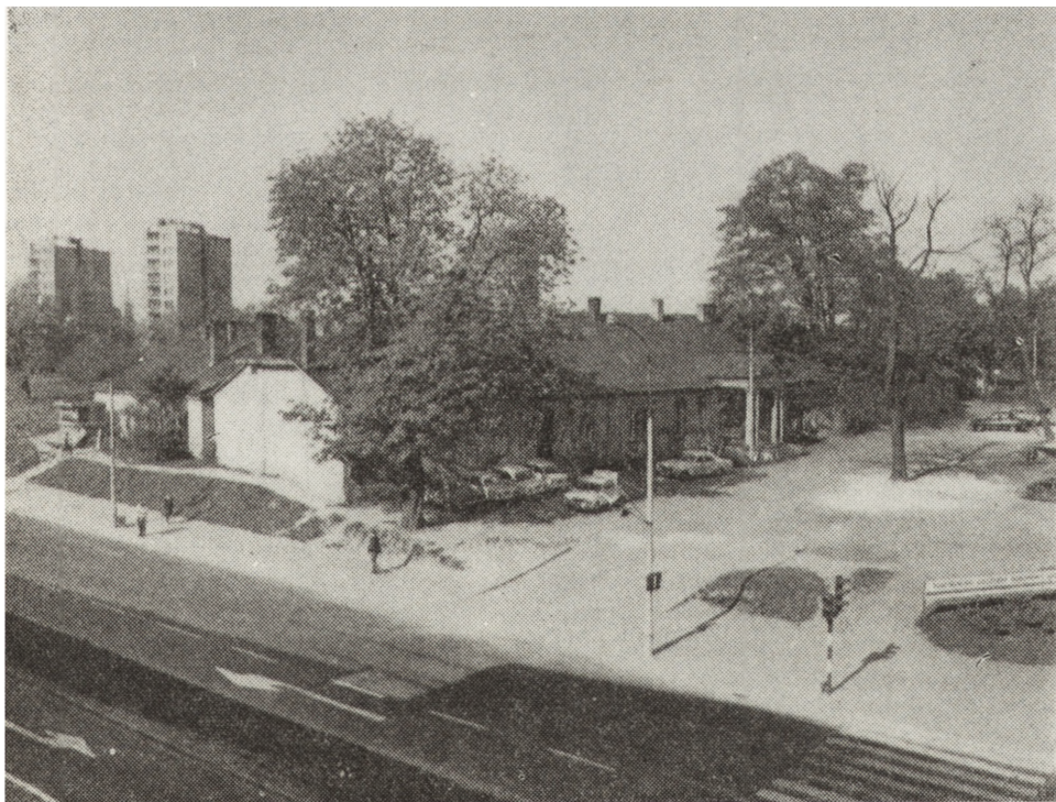
Ryc. 4. Dwór, widok od północnego wschodu na elewację północną
