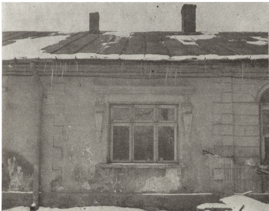
Ryc. 6. Dwór, elewacja północna, widok okna z obramieniem hermowym
