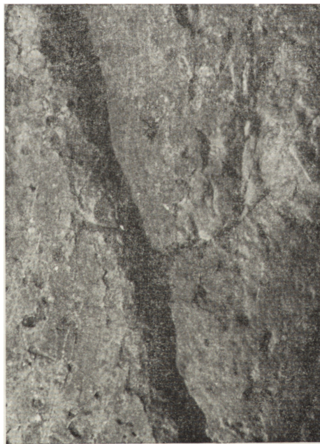
Ryc. 9. Przed konserwacją — makrofotografia mechanicznych uszkodzeń powierzchni kamienia
