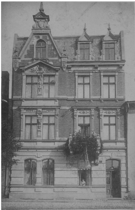
Fot. 4. Budynek przy ul. Fosa Staromiejska 16, w którym mieszkał ks. Łaszewski. Budynek rozebrano w 1910 r., przerabiając go na tzw. Łuk Cezara
