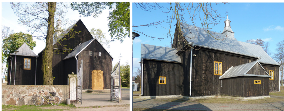
Fot. 7. Kościół pw. Św. Michała Archanioła w Umieniu, widok od zachodu i południa. Fot. J. Nowiński.
