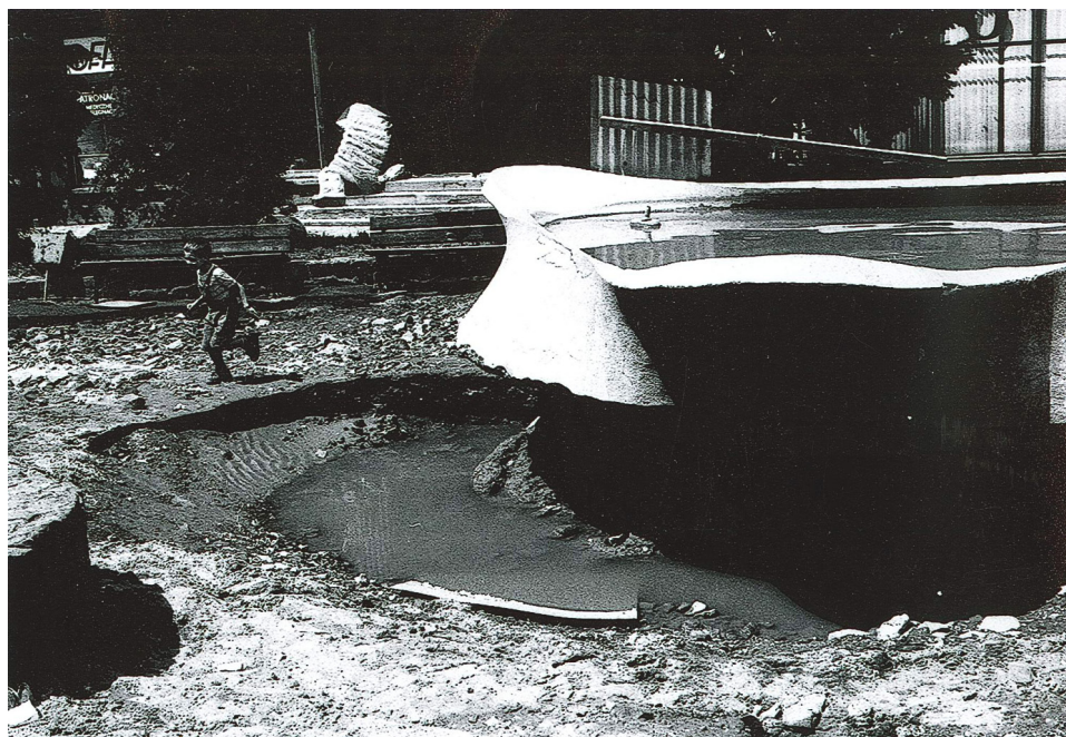
Fot. 2. Opole po zejściu wody – lipiec 1997 roku. Fot. Przemysław Nijakowski
